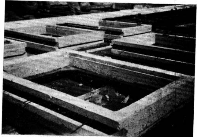
Fig. 8. — Marcos de ventanas después de desarmar los moldes, pero aun sobre las bases donde han sido fabricados.
