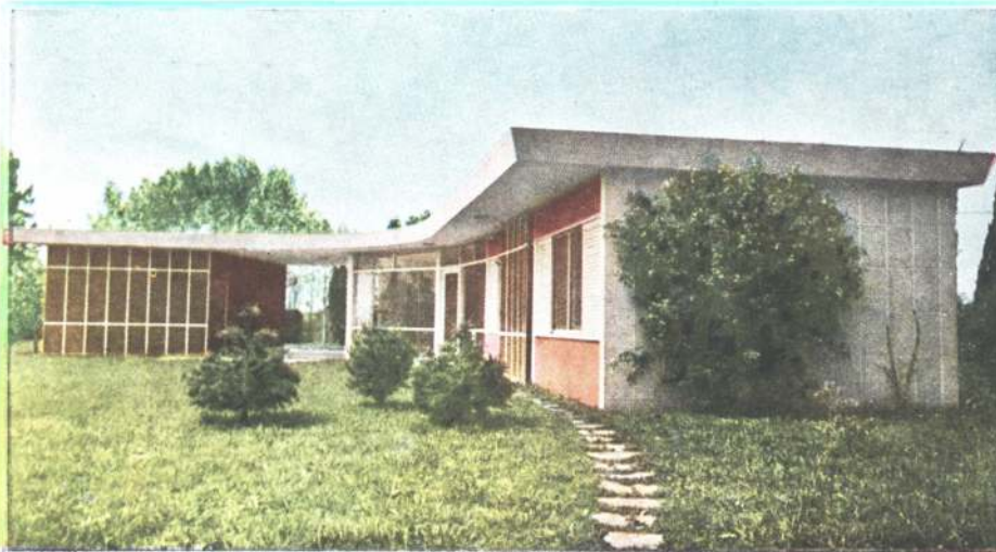
1. Vista desde el parque; los postigones de la terraza cubierta y la sala están quitados y colocados, uno sobre la pared trasera del garage, y el otro, en el exterior de la sección del baño; los baldosones blancos de los laterales tienen juntas de cemento blanco. Los artefactos de iluminación de la galería son embutidos.
