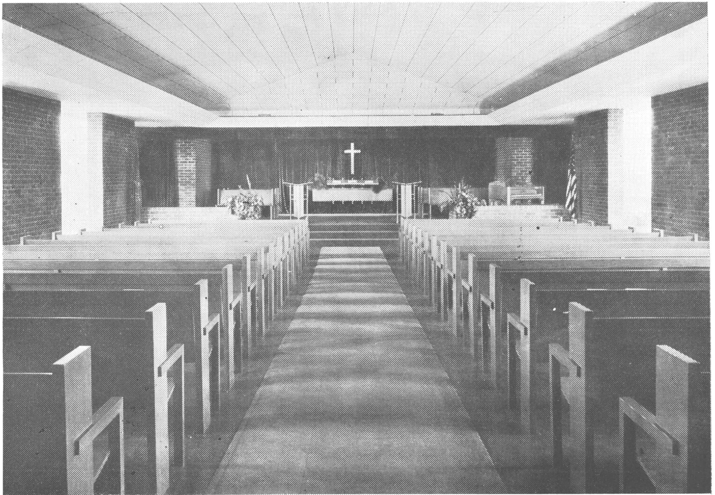
El interior de la iglesia, tal como el exterior, es a la vez digno y sin pretensiones. Las paredes de ladrillo a la vista, llevan piezas livianas de acero que soportan el techo y el cielo raso.
