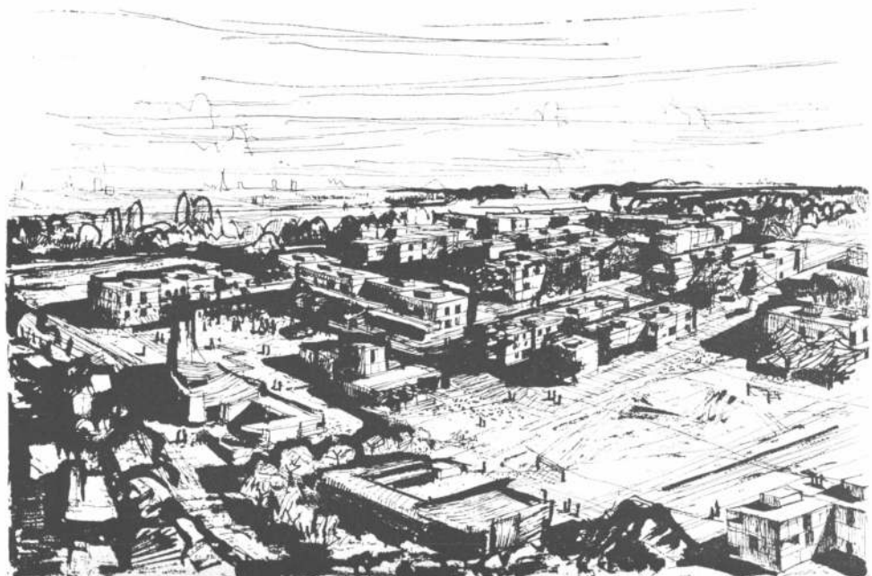
Vista aérea; en primer lugar, centro secundario y cancha de fútbol.
