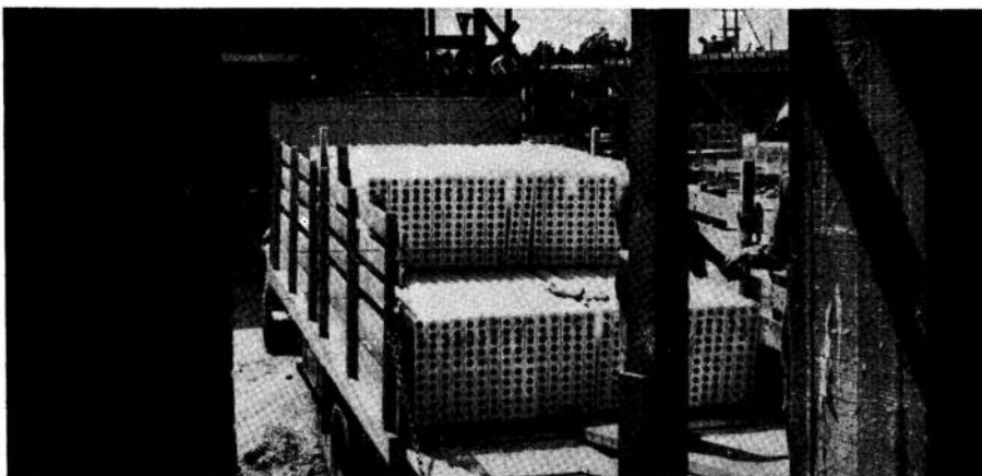
Los paneles llegan a la obra en camiones, apilados de canto.
