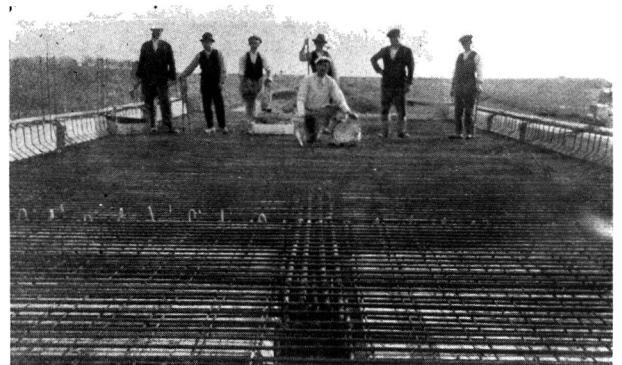
Armadura de acero de la losa. Hormigón: 1 : 1,5 : 3.
