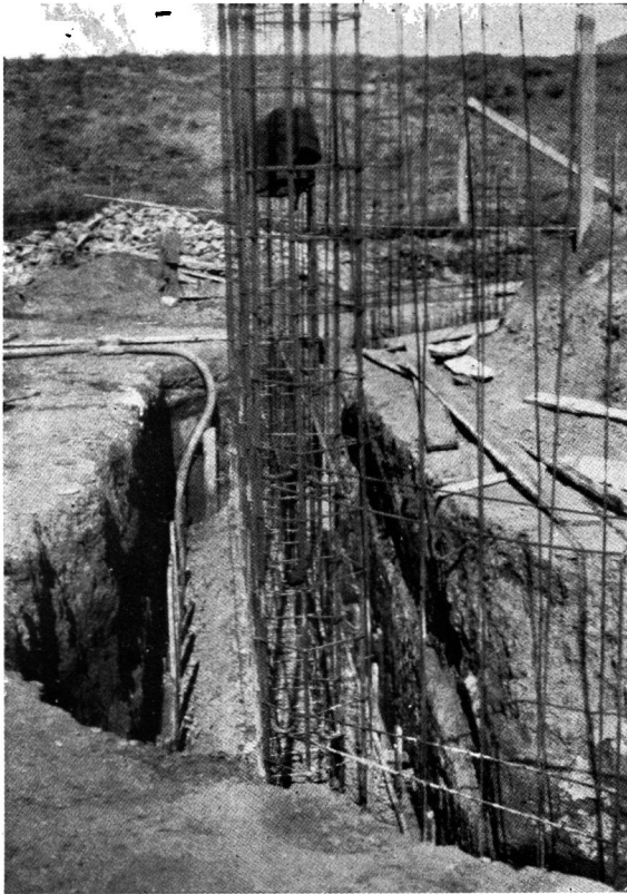
Vista del cimientado de los estribos. Fundación directa sobre tosca. — Base de hormigón, 1 : 2 : 4.— ancho 1,50 metros; alto 0,60 metros.— Zócalo, ancho 1,00 metro; alto con chafflán 1,30 metros; la armadura de acero de los mamparos y alas fue empotrada 0,30 m. en el zócalo.
