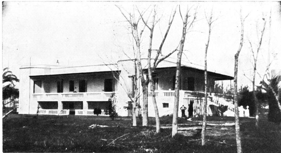
VISTA DEL FRENTE LATERAL ANTES DE LAS REFORMAS
