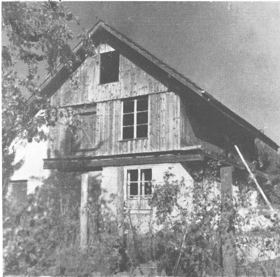
La construcción vista del oeste, antes de la renovación.
