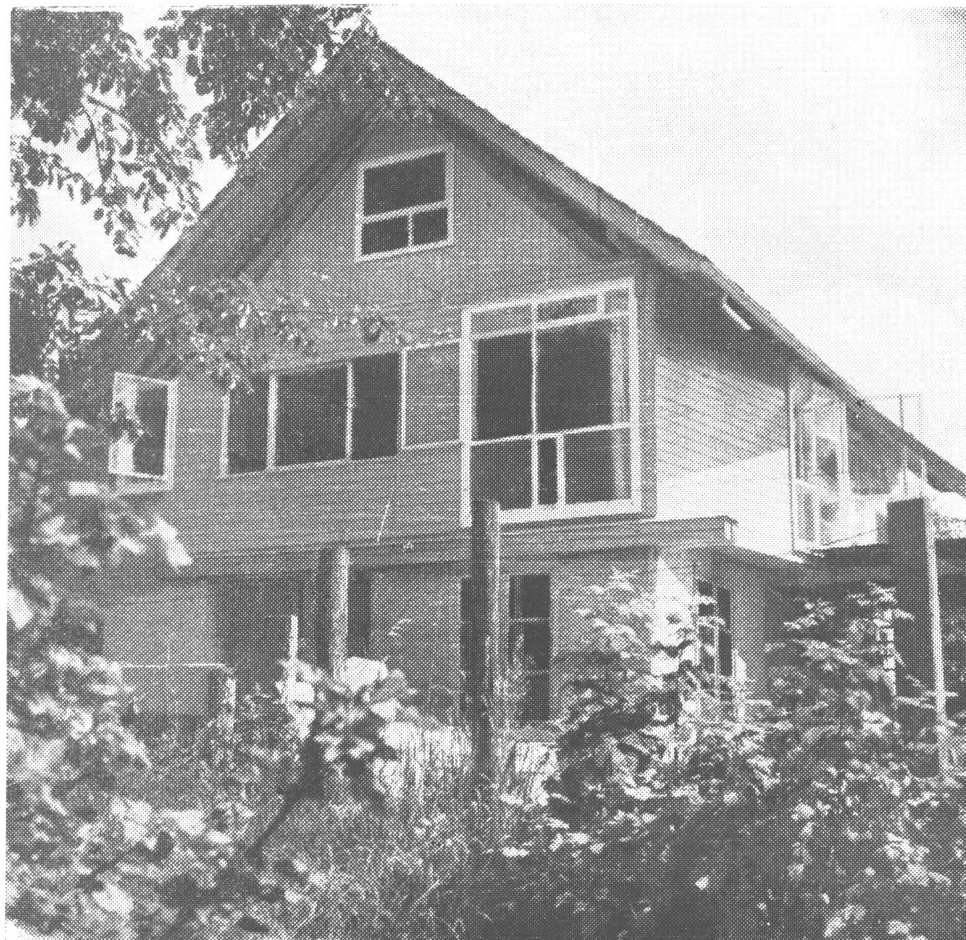
La construcción, vista del oeste, después de la renovación. Las ventanas, a excepción de la central del primer piso —para la que se ha usado un marco existente— abren hacia el exterior y están subdivididas en base a un módulo cuadrado de 0,64 x 0,64. La parte de la estructura portante preexistente ha sido barnizada en oris azul, las nuevas paredes de revestimiento externo, en gris claro. Los marcos de las ventanas son blancos.
