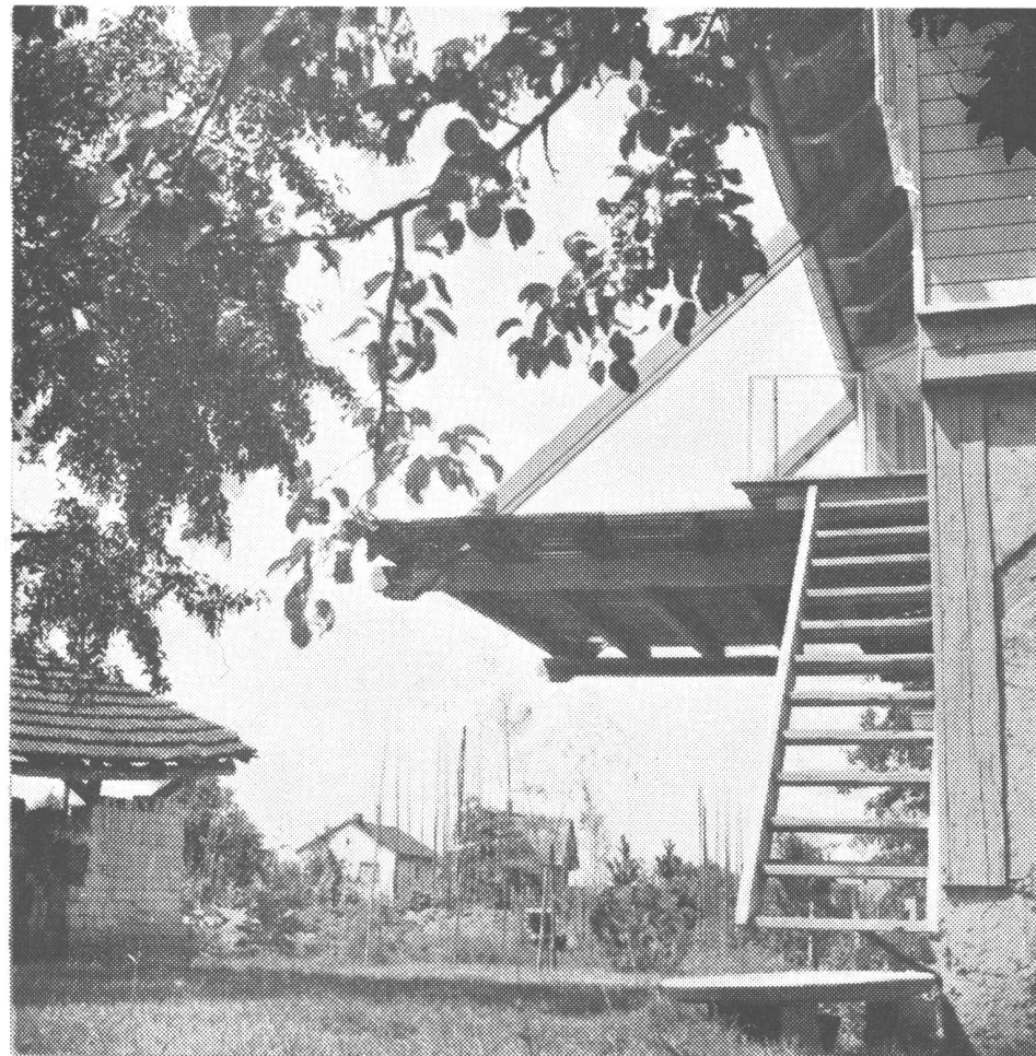
A la izquierda: la construcción vista del este, después de la modernización. Sobre el frente sud se ha suspendido un ancho balcón de las vigas prolongadas del techo. Abajo: el interior del primer piso antes de la modernización.
