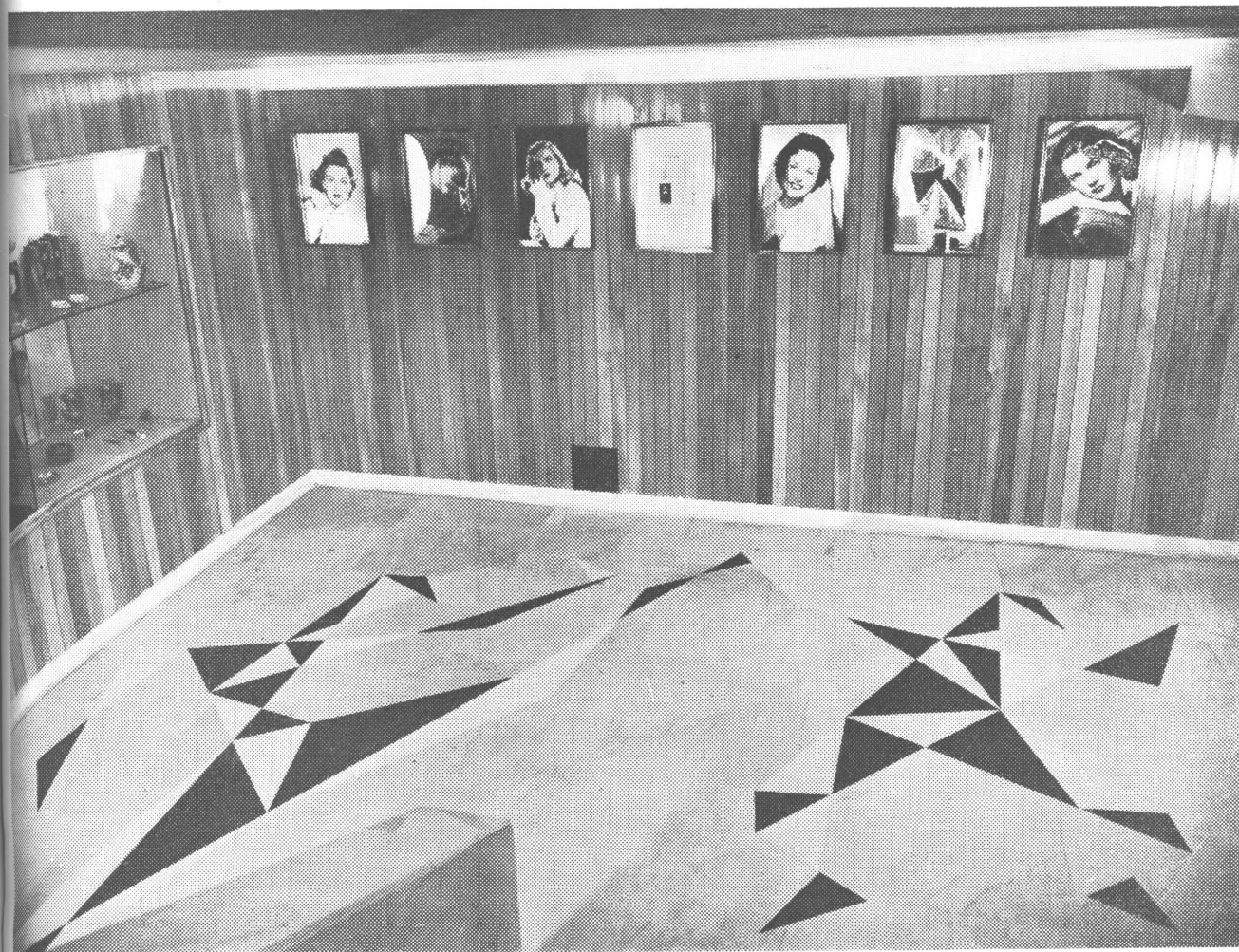
La boletería; sobre el pavimento de mármol blanco, figuras de arlequín trazadas con mármol negro y rosado.
