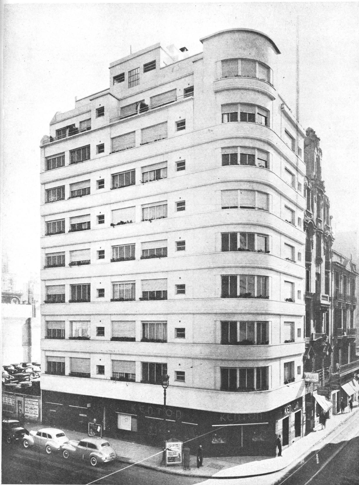
Fachada de la casa, situada en Corrientes y San Martín. Revestimiento del frente de la planta baja de granito del Brasil. Entrada del primer hall de mármol Lunel; del segundo hall, revestimiento de roble. Piso de mosaico.
