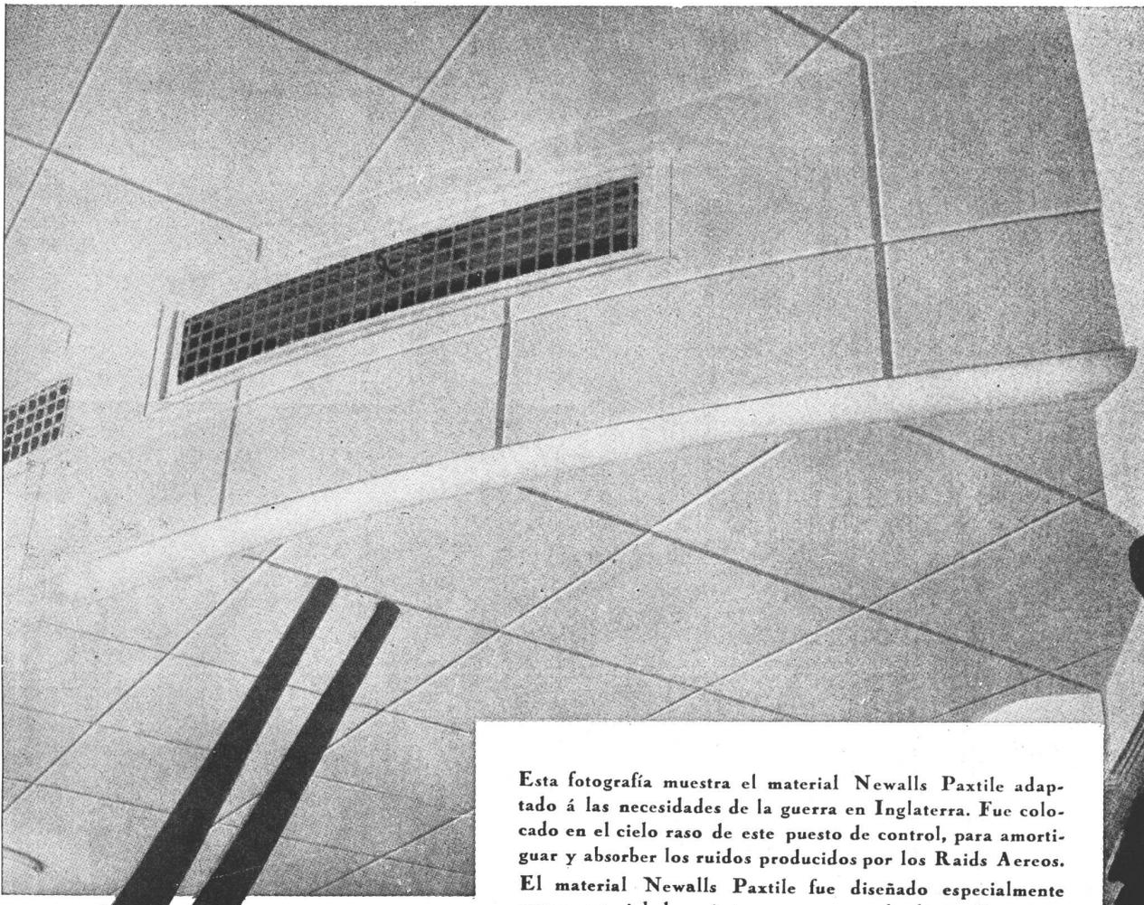
Esta fotografía muestra el material Newalls Paxtile adaptado á las necesidades de la guerra en Inglaterra. Fue colocado en el cielo raso de este puesto de control, para amortiguar y absorber los ruidos producidos por los Raids Aereos.
