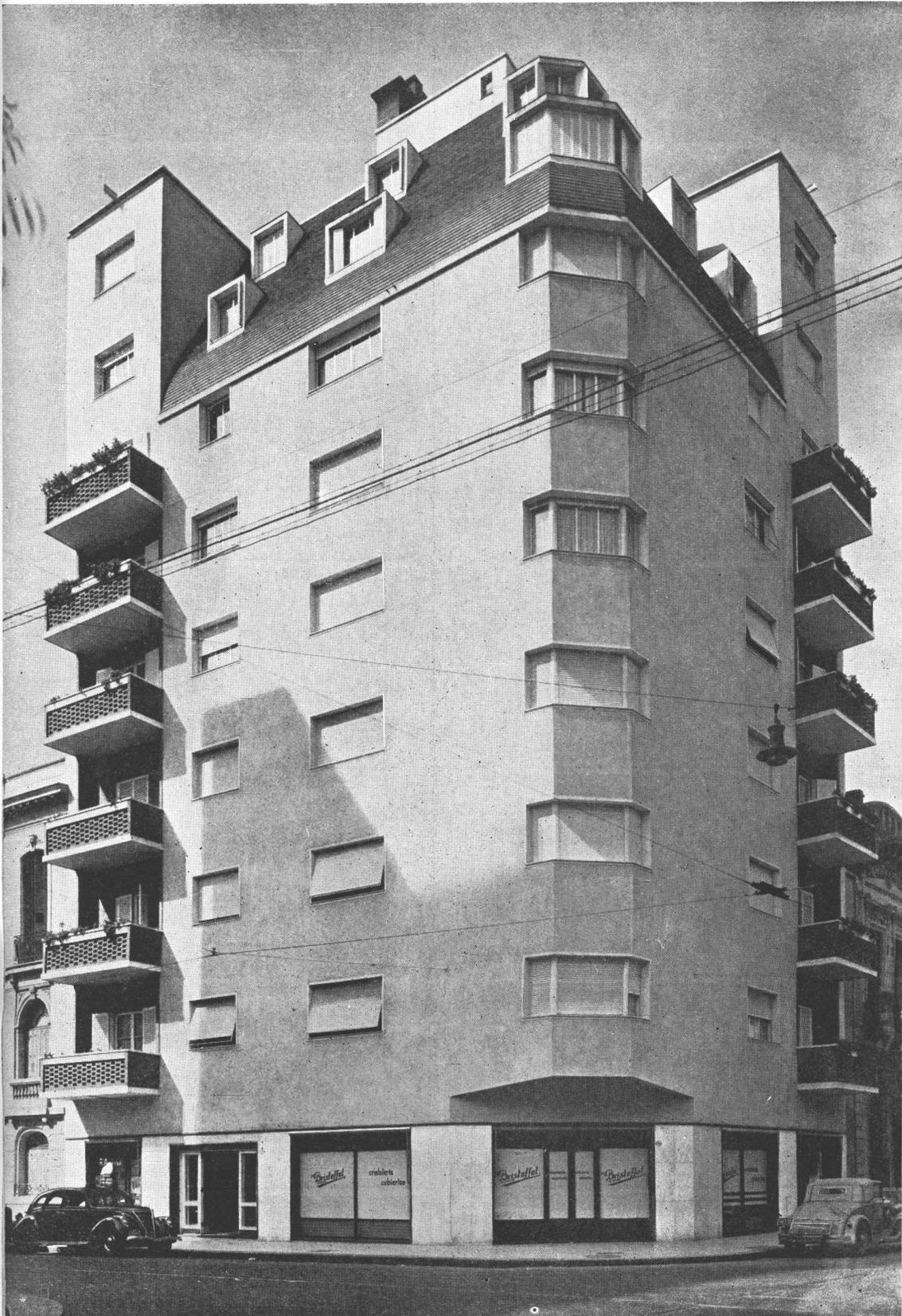
Fachada revocada color beige, planta baja revestida con mármol de Córdoba blanco, martelinado; moquetas y cornisa de granito rojo de San Luis, lustrado. Los balcones y nichos de los pisos altos son de ladrillos repretados. La mansarda está cubierta con un techado de tejas planas.
