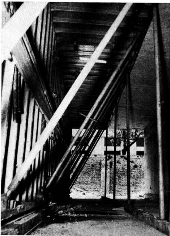
Vista interior del túnel con barras para mantener horizontal la parte superior del molde. A la derecha se ve parte de una unidad ya desencofrada. La barra se alarga con un movimiento de rotación.
