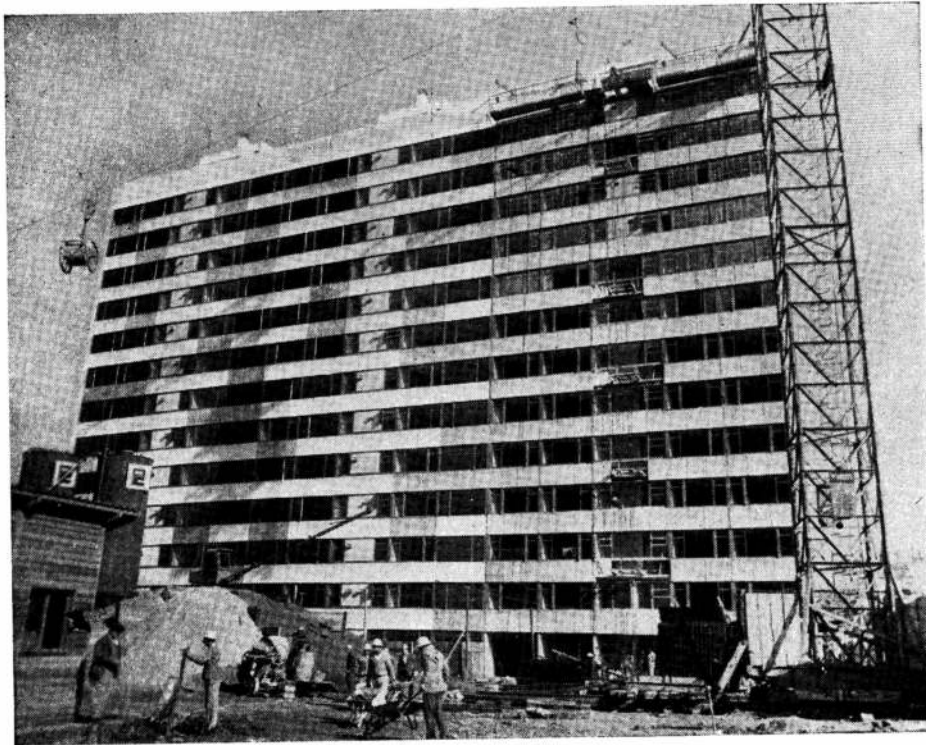
Un edificio prácticamente terminado con los antepechos y carpintería colocados en su totalidad.
