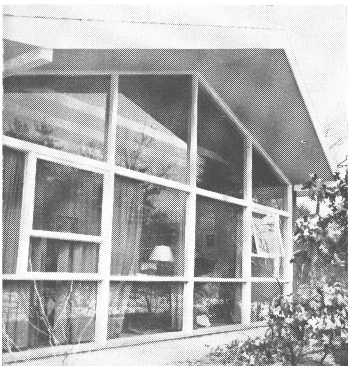
El techo en pendiente obedece al deseo de armonizar la casa con los edificios circundantes y valorizar el espacio disponible interior.
