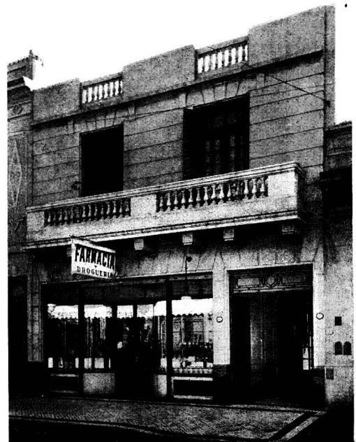
Vista de la parte del frente ejecutada hasta la fecha
