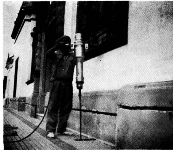
Un operario hincan una jabalina utilizando un potente martillo eléctrico; se utilizan martillos de la marca Kango, en el modelo "H".
