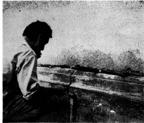
Puesta la banda de cobre, los palos se utilizan para embutir los electrodos. Cerca de la mano del operario se ve la caja de empalme.
