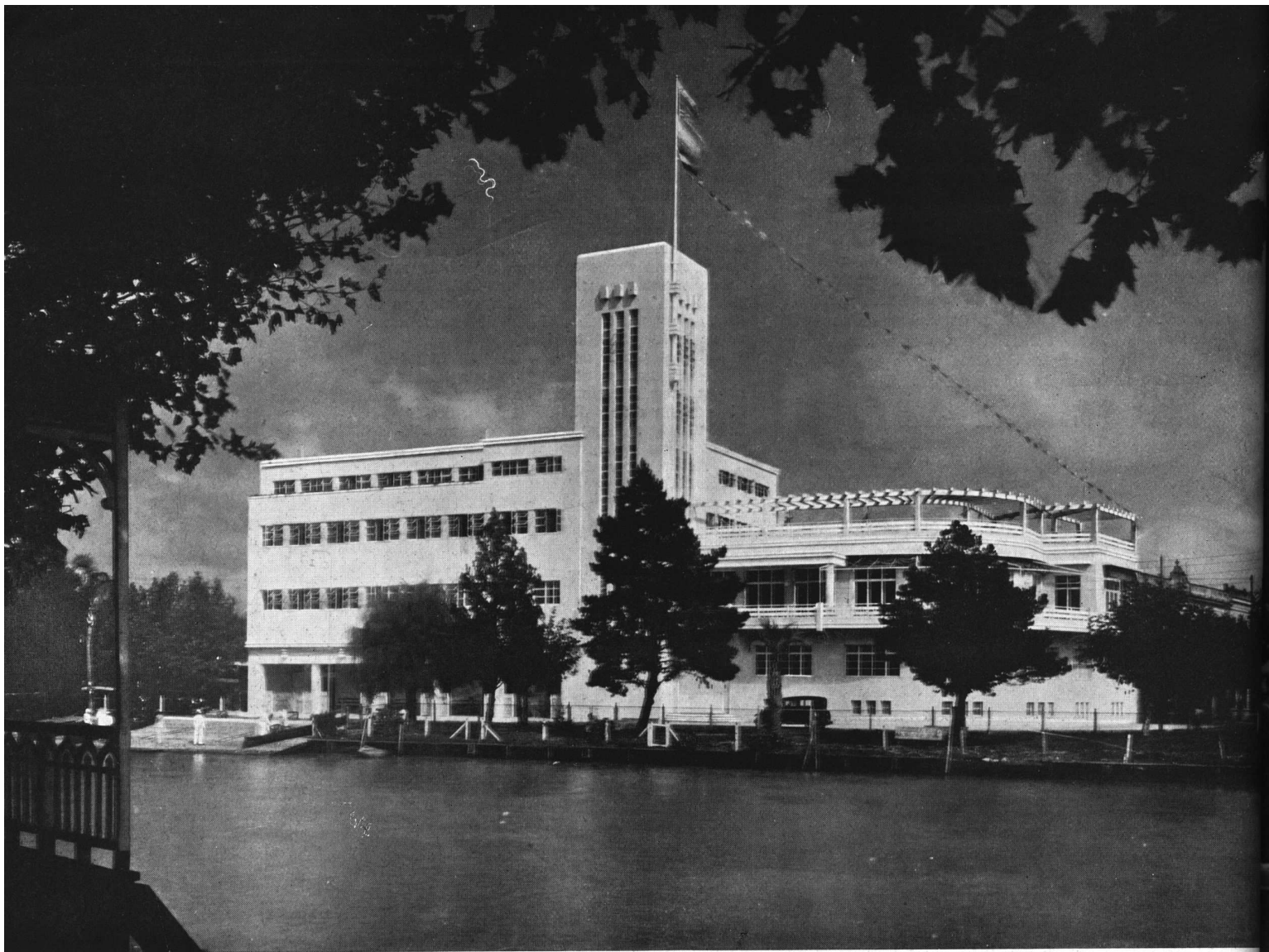
Nuevo edificio del Ruderverein Teutonia en el Tigre VISTA DESDE EL RIO Petersen Thiele y Cruz, Arqs.
