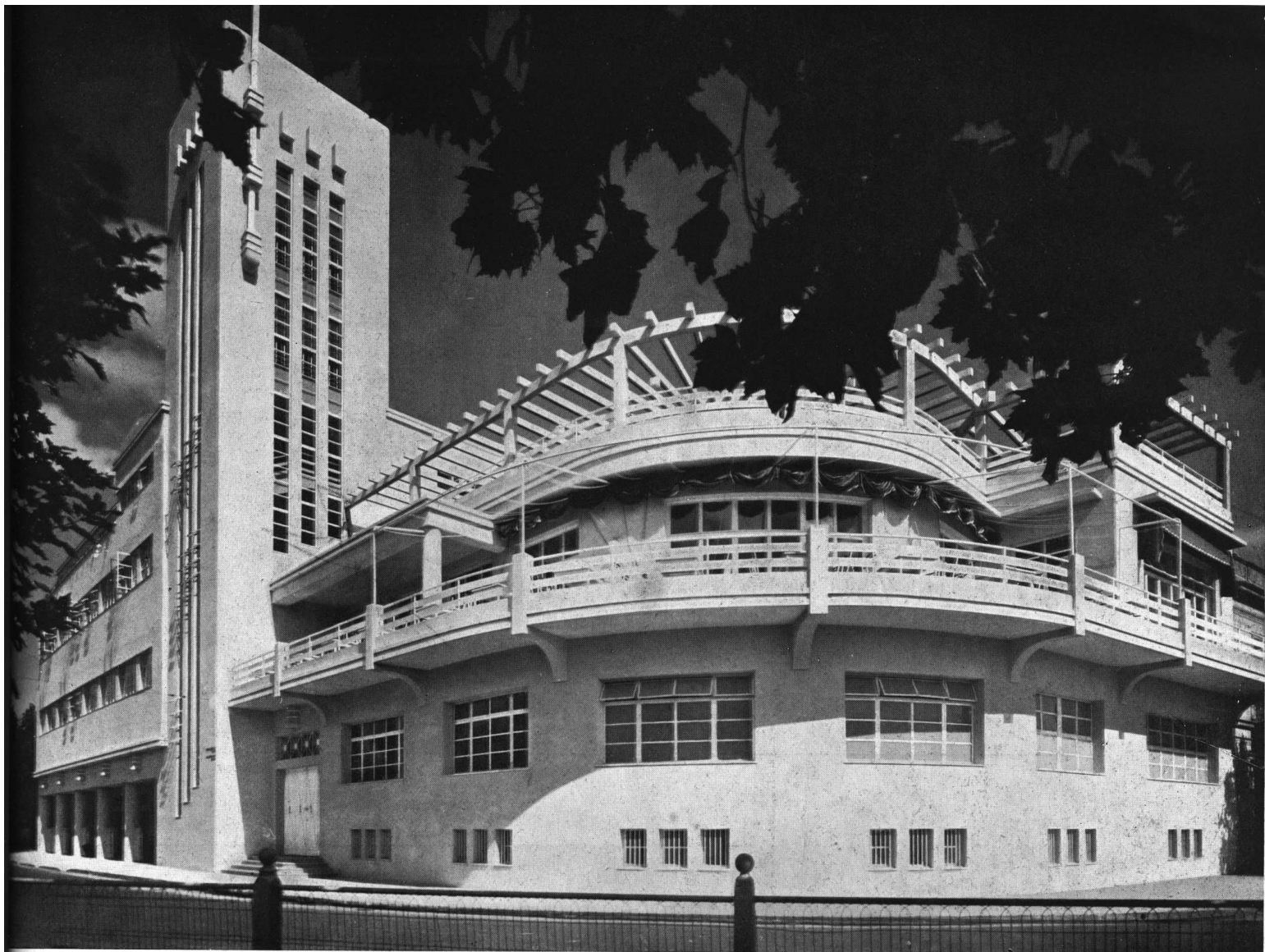
Nuevo edificio del Ruderverein Teutonia en el Tigre VISTA DESDE LA CALLE
