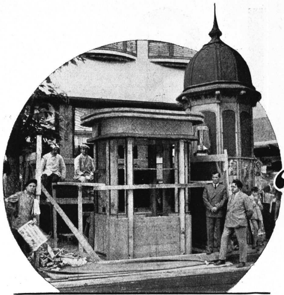
La fotografía presenta un aspecto de la construcción del quiosco de hormigón que pronto habría de reemplazar al que puede verse en la parte derecha del grabado. Dicha construcción se realizó en pocos días mediante el empleo del cemento 'INCOR'
