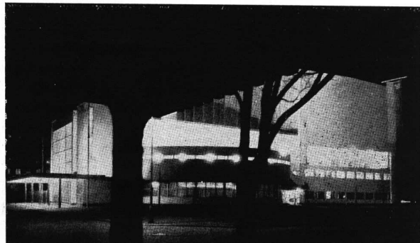
Moderna sala de conciertos en Helsingborg, Suecia. Arq. Sven Markelius. (De Moderne Bauformen, Octubre 1933)
