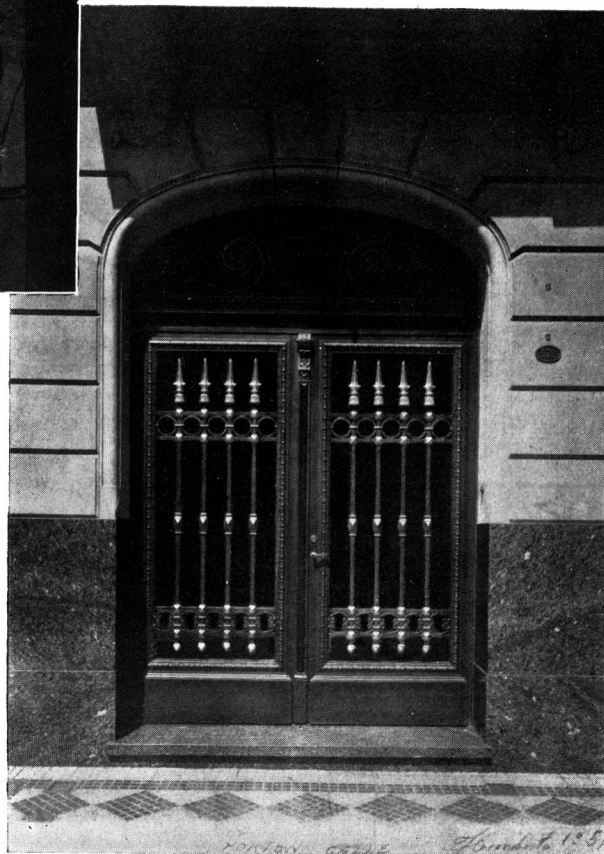
Puerta de calle
