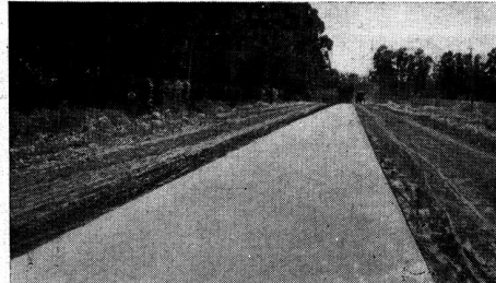
Este tipo de camino de hormigón permite una futura ampliación, cuando el aumento del tránsito lo requiera.
