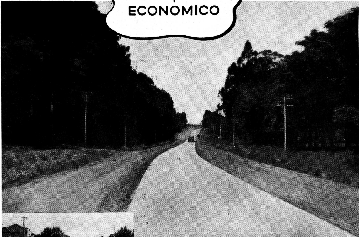
Un aspecto del camino de hormigón de 3 metros de ancho, que une a Moreno y General Sarmiento.
