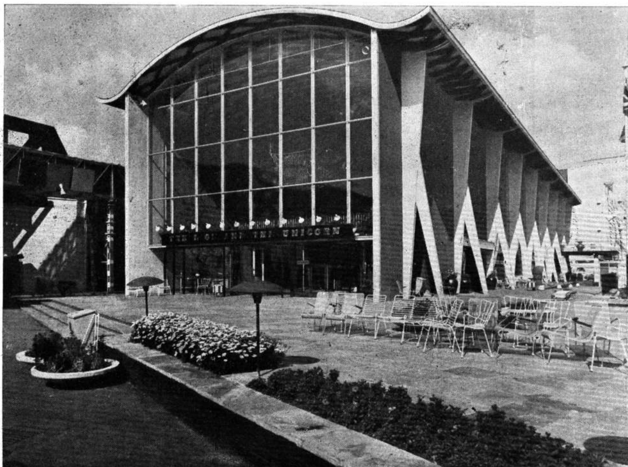
El edificio del León y el Unicornio, excelente ejemplo de arquitectura cuyas formas derivan del uso de los materiales modernos, lo que ha permitido que todo el edificio, excepto el armazón, sea de vidrio.
