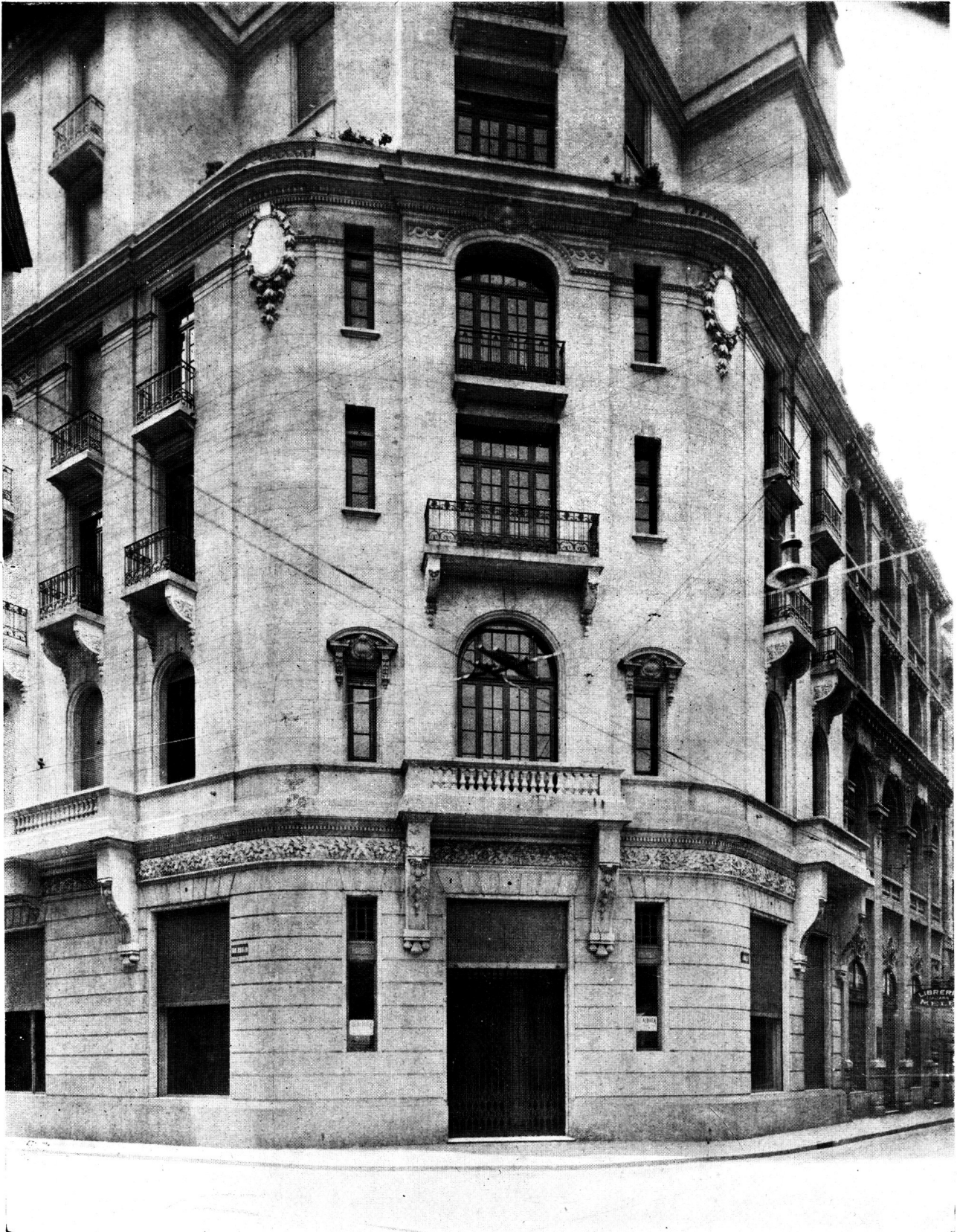
CASA DE RENTA, LAVALLE ESQ. SAN MARTIN: DETALLE DE LA OCHAVA
