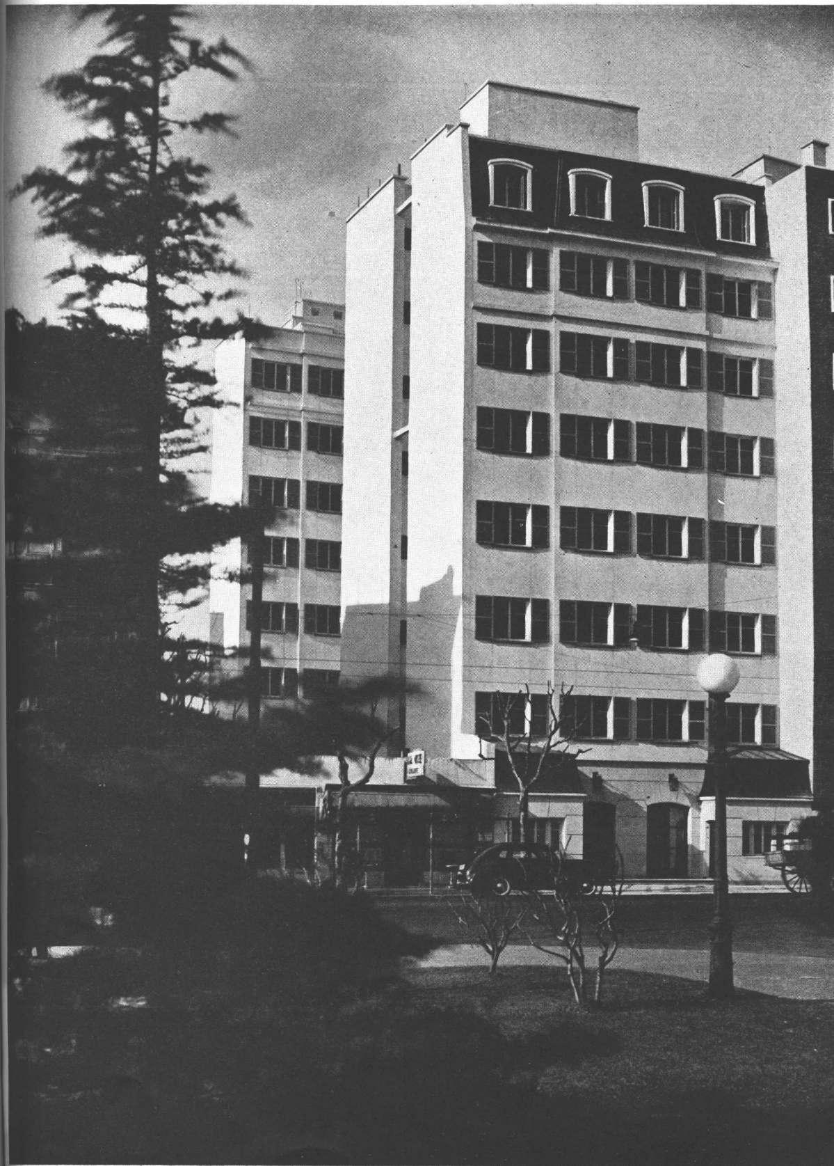
La fachada de la casa, situada en la calle Las Heras 2259.
