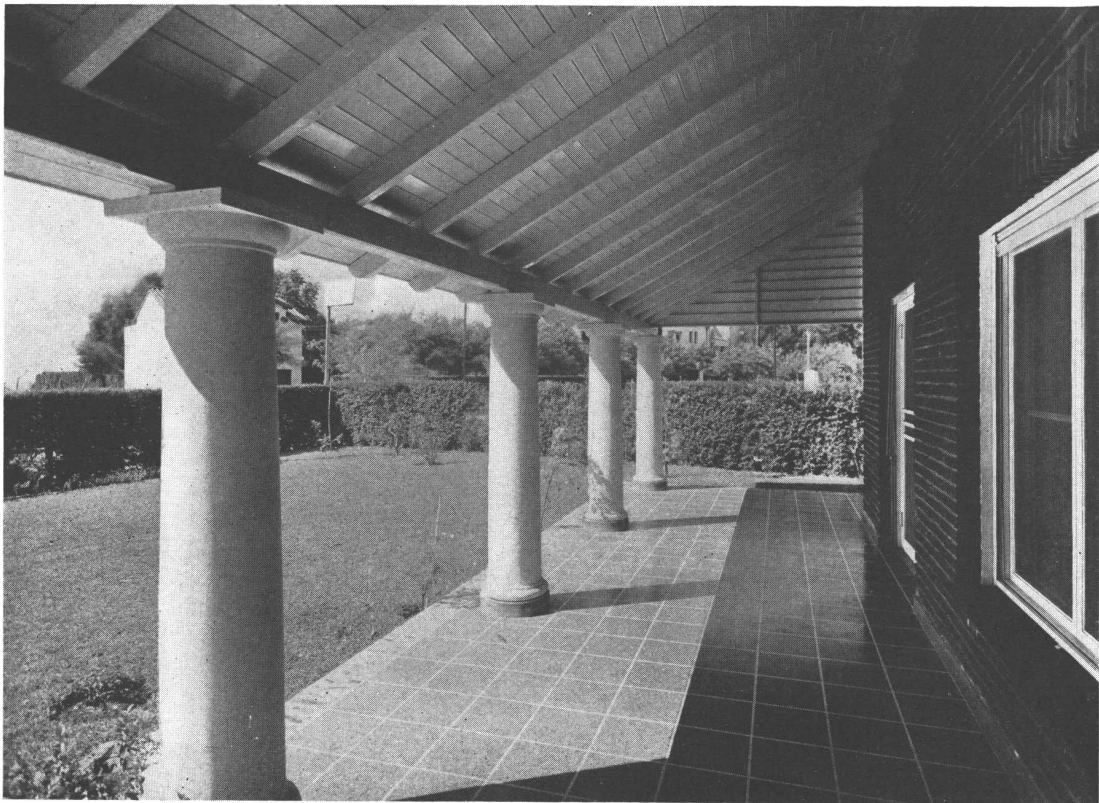
La galería. Piso de mosaico granítico rojo con juntas blancas, anchas. Columnas con revoque imitación piedra. Entablonado y vigas blancas.
