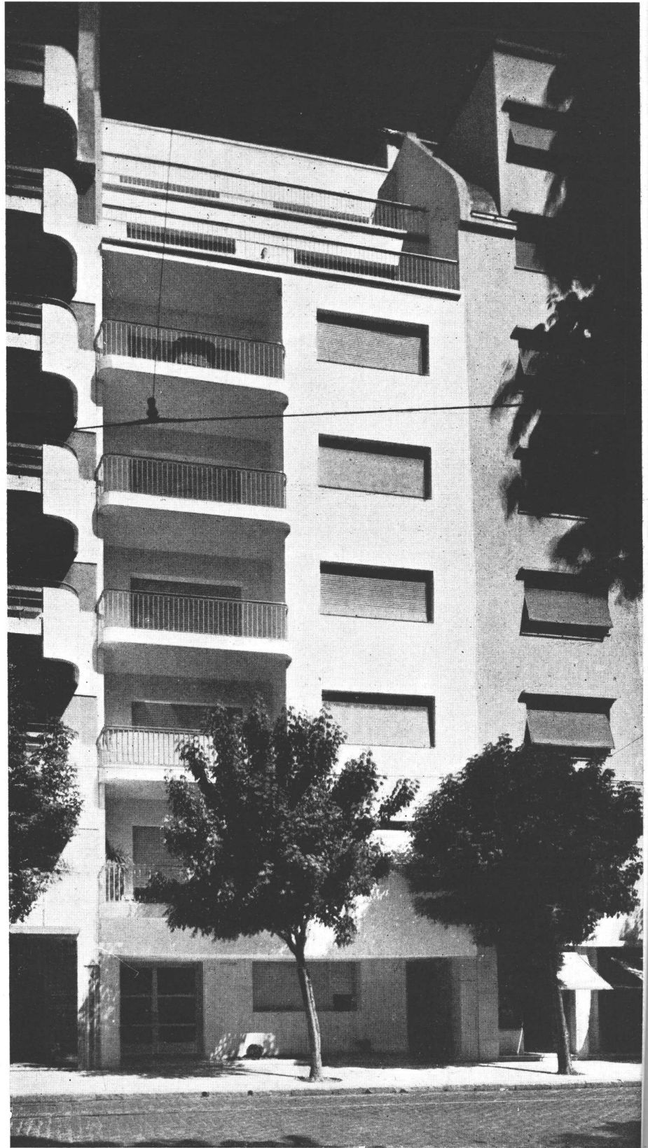
La fachada del edificio situado en la calle Cánning 2681
