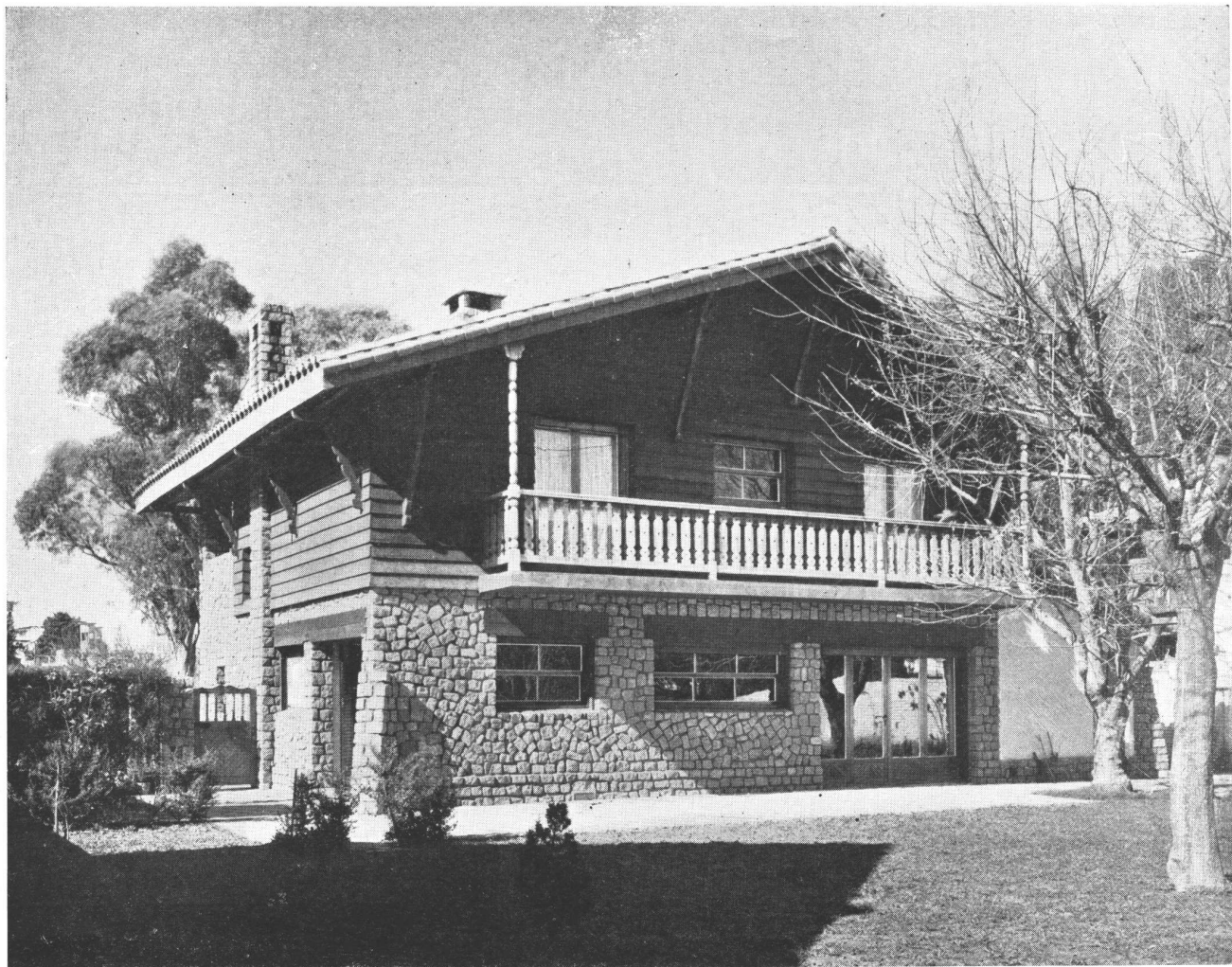
Contrafrente mostrando parte del jardín, todo en piedra y madera, con su clásico balcón corrido y refuerzo del alero del techo
