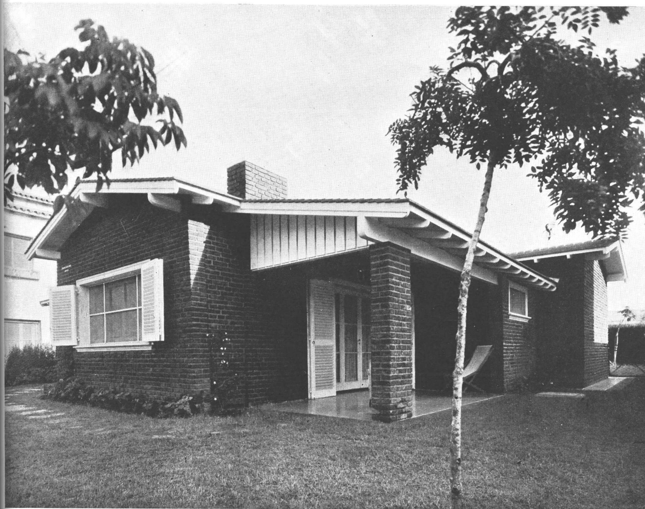
La fachada lateral de la casa, situada en la calle Perú 648 y propiedad de la Sra. Martha E. Livinston Salas
