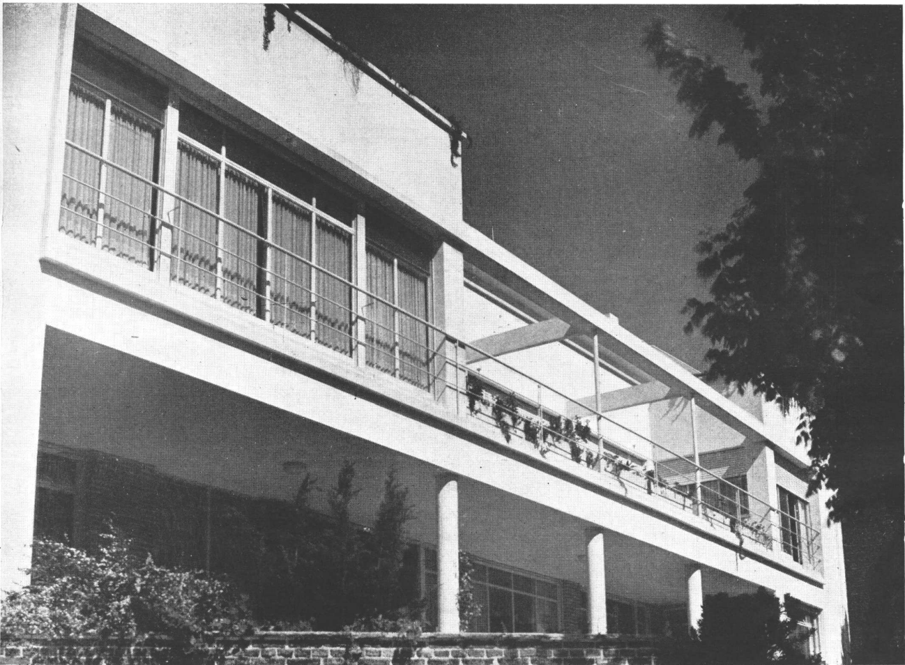
La fachada lateral
