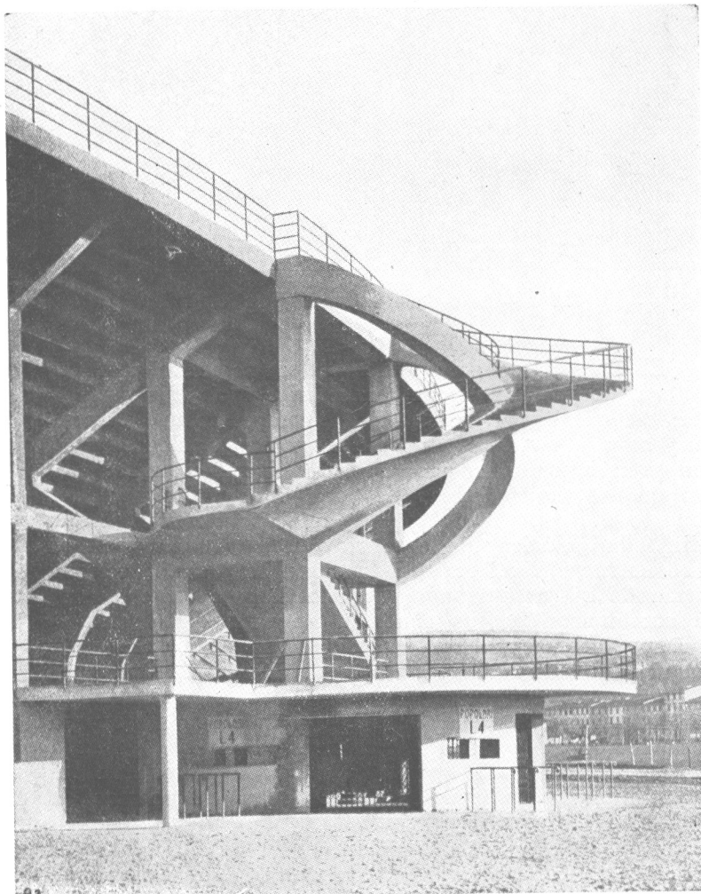
Fig. 3. — Estadio Giovanni Berta. Florencia. (Una de las escaleras)
