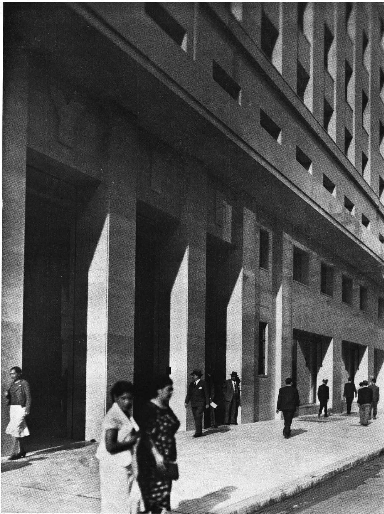
DETALLE DE LA FACHADA
