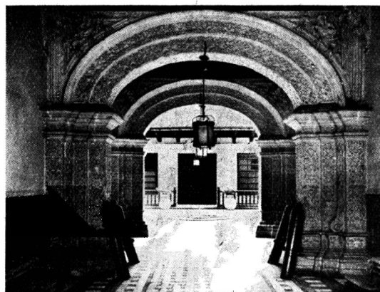
Arquería de entrada al Palacio de Torre Tagle.
