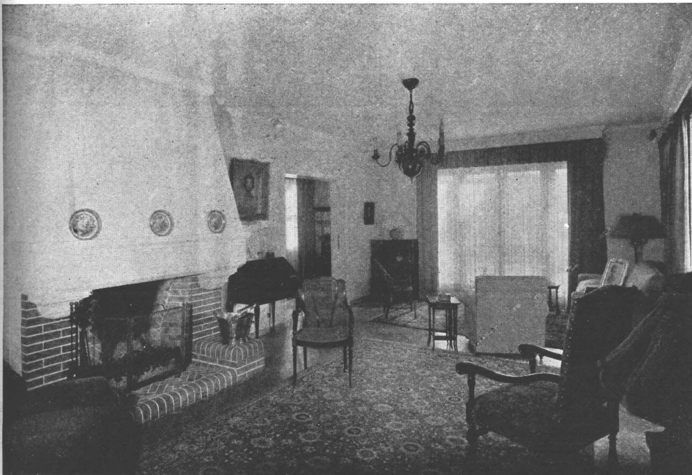
Arriba , vista de un rincón íntimo del living room. Al fondo se distingue la reja decorativa que lo separa del jardín de invierno. — Abajo , vista parcial del living room mostrando el hogar ejecutado en ladrillo de máquina, con la campana en imitación piedra.
