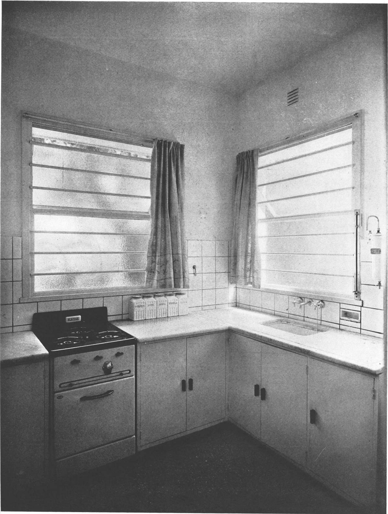
Interior de la cocina con grandes aberturas; piso de mosaico granítico, mesas de mármol blanco. Revestimiento de azulejos blancos. Armarios bajo las mesas.
