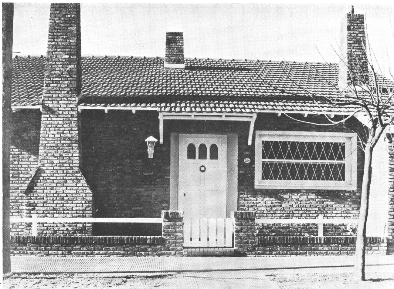
Detalle de la entrada principal sobre la calle Balcarce; la casa está ubicada en la calle Balcarce 2110 y es propiedad de la Sra. Elena P. de Verrier.
