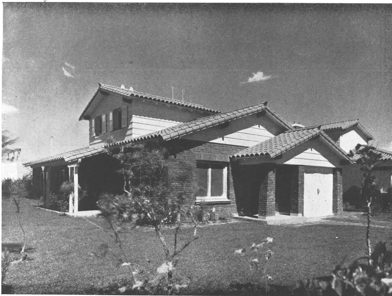
El ángulo Noreste. Los muros son dobles con cámara de aire intermedia. Revoque pintado al aceite.
