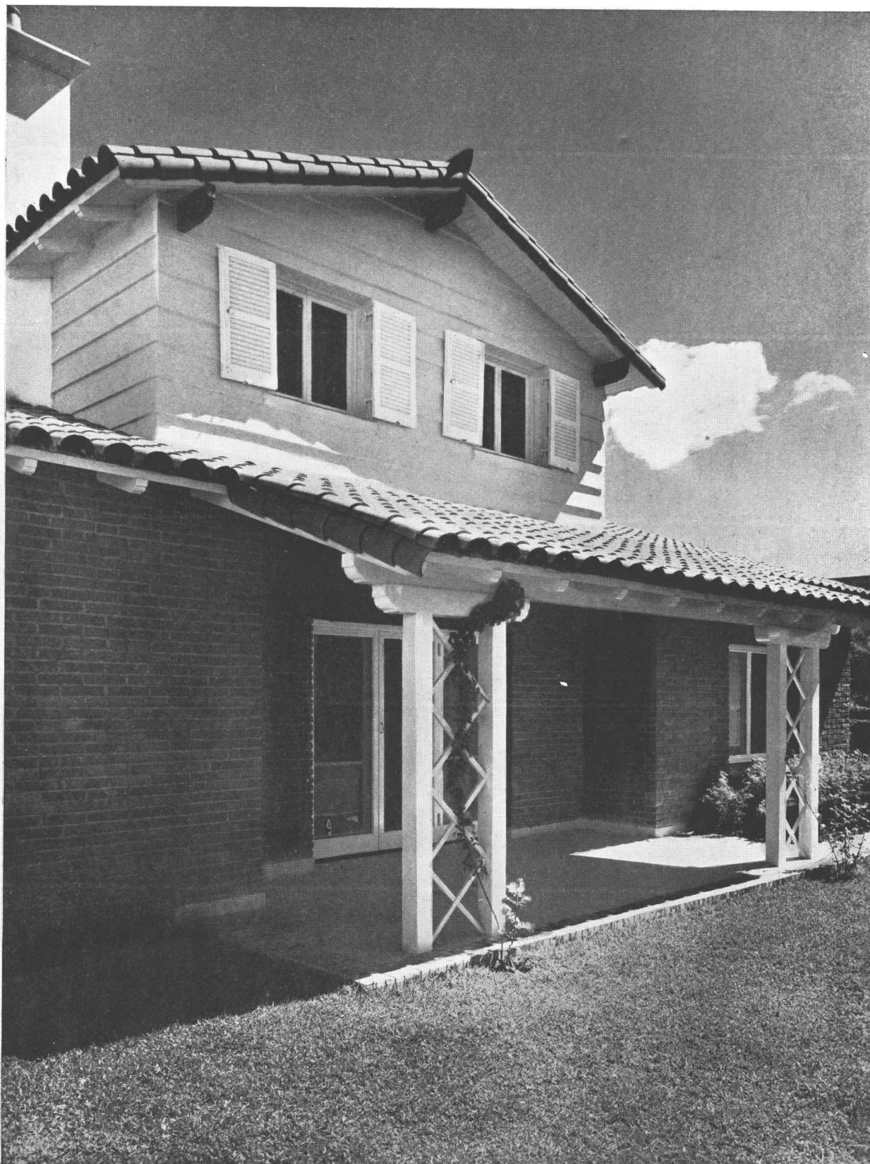
Vista parcial de la galería, con pilares de madera dura.
