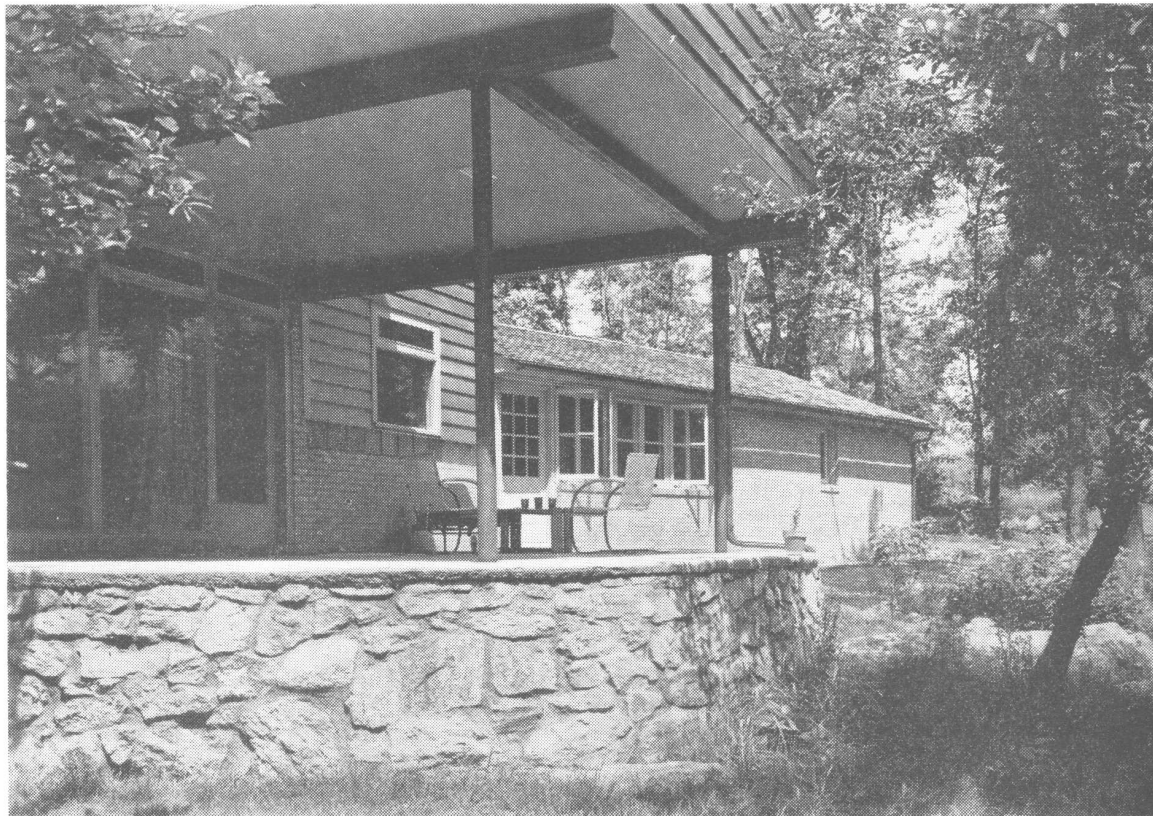
Vista a través de la terraza hacia el ala de servicio.
