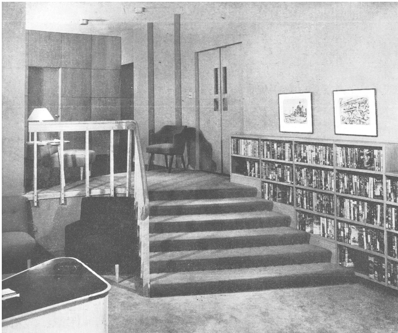
Escalera que une el salón de recepción con el balcón donde están las oficinas para recibir visitantes. Pared del fondo recubierta de cuadrados de terciado de roble.
