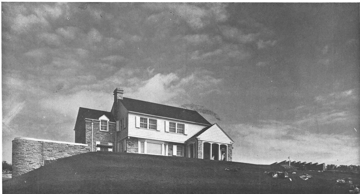
Vista mostrando la ubicación dominante del edificio.
