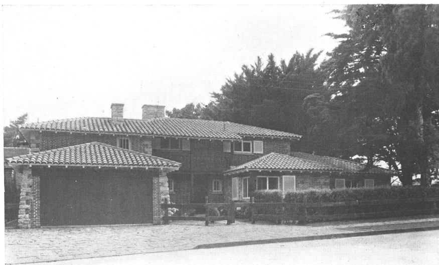
La fachada principal que mira al Sud-este. La casa está ubicada en la calle Primera Junta, esquina Carlos Pellegrini.
