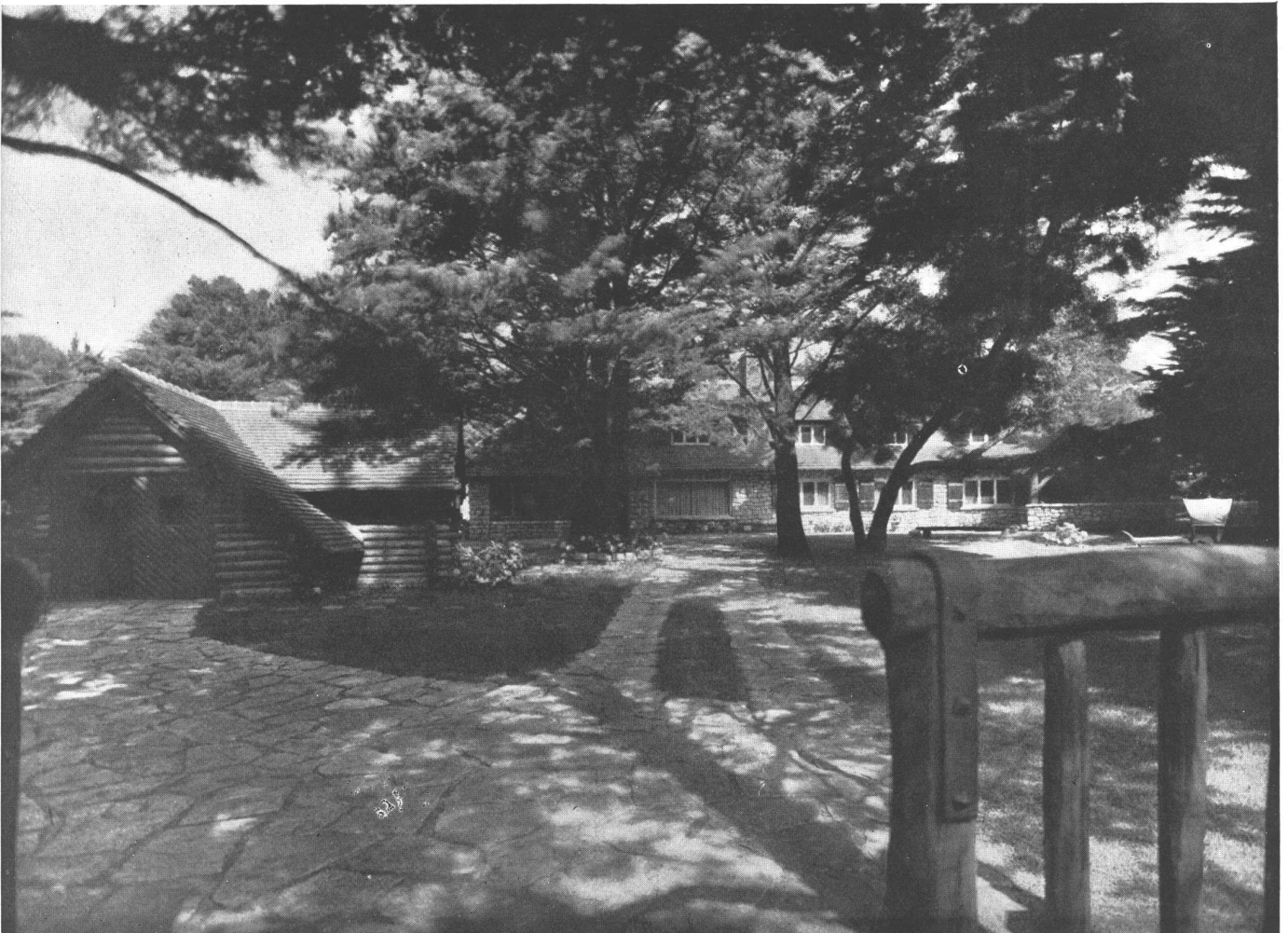
Vista de las casas; en primer plano, el garage.
