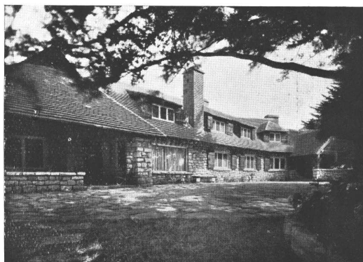
Chalet "LOS TRONCOS" del Dr. EDUARDO CORNEJO SARAVIA y "TATULIT" - Chalet del Sr. RICARDO GREYER Gral. Urquiza 3435 Arquitecto ALBERTO RODRIGUEZ ETCHETO SARTORA E HIJOS - CONSTRUCCIONES
