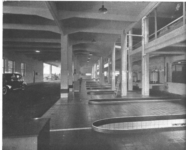
Las fosas de engrase técnico en la planta baja.
