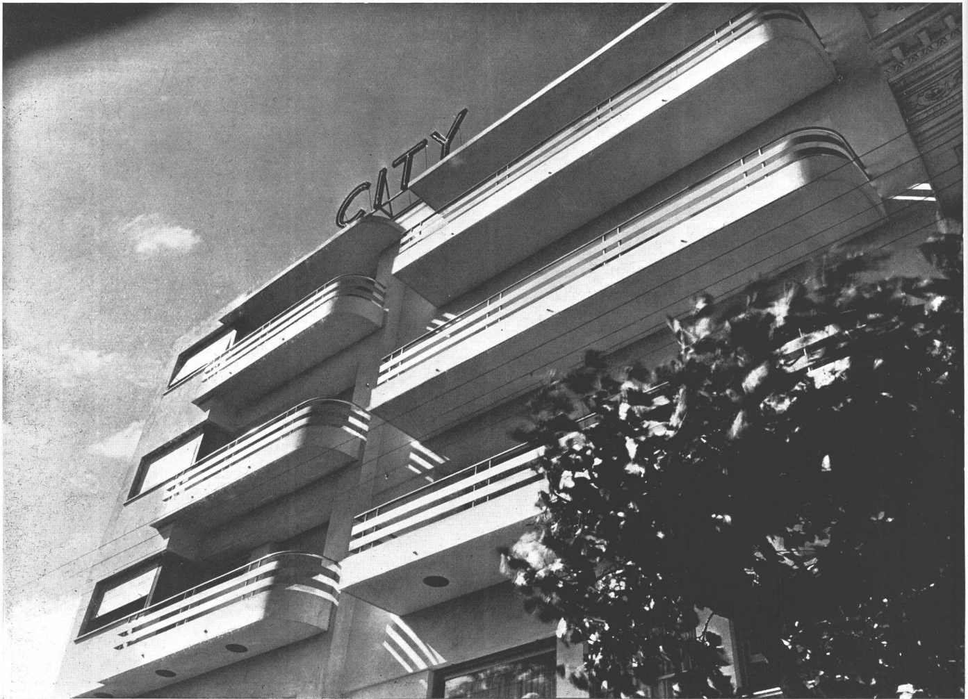
Un detalle de la fachada del edificio.
