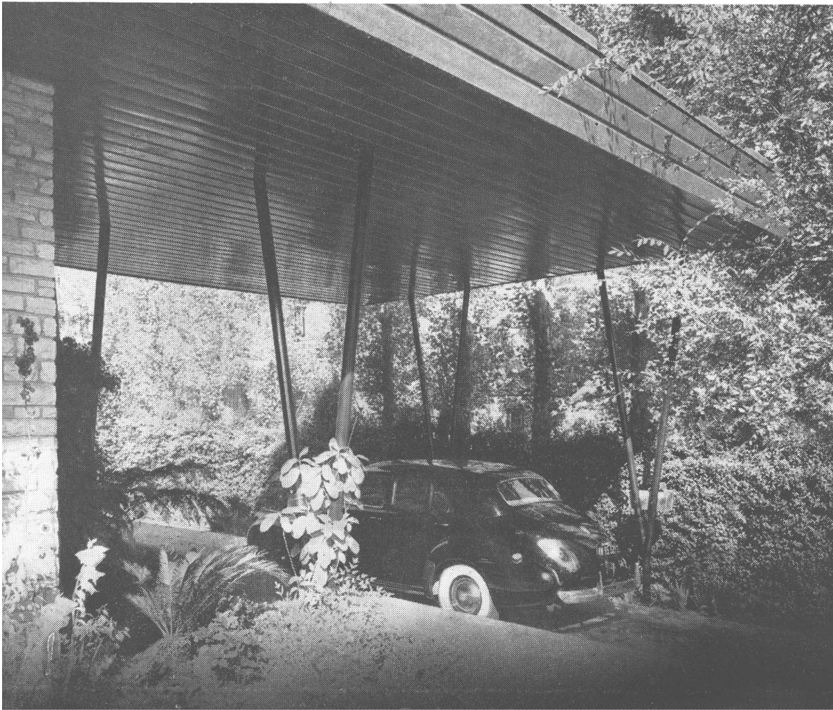
El techo plano de la casa, prolongado hacia la derecha y sostenido por caños de hierro, forma el guardacoches, poco costoso y eficiente.
