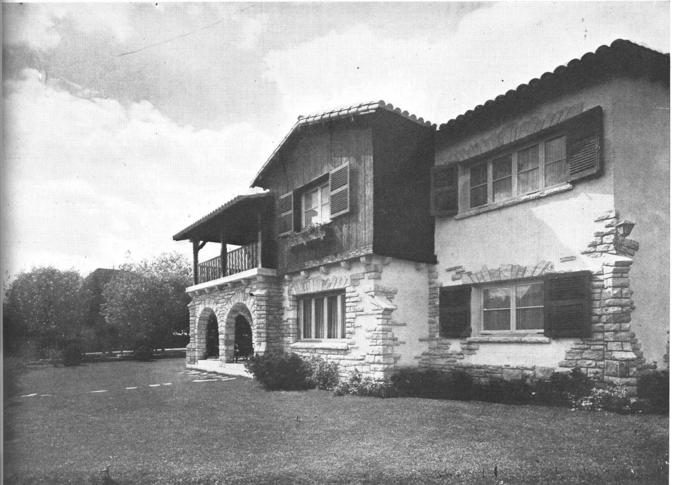
Fachada lateral; contrafuertes y arcos de la galería en piedra Mar del Plata. Paredes en revoque rústico. Balcón y cuerpo alto en lapacho azulado, barnizado color natural.
