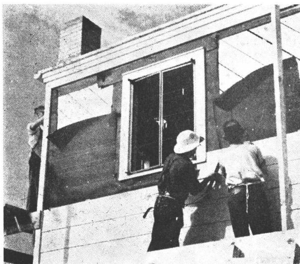
**TERMINADO.** — Sobre el armazón de las paredes se aplica un papel especial y largas piezas de cemento amianto. Las puertas y ventanas, armadas en los talleres, reciben una primer mano de pintura antes de instalarse.
