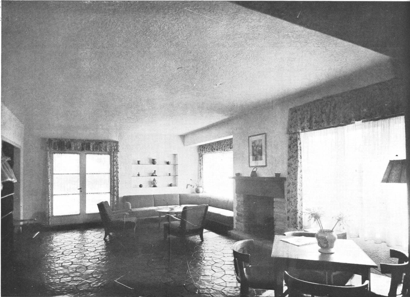
El living room visto desde el hall. Piso de mosaico cerámico californiano de dibujo hexagonal. Paredes y cielo raso en revoque rústico dosado con polvo de piedra Mar del Plata blanca. Chimenea con pilares de piedra Mar del Plata rústica, viga y repisa de lapacho azuelado, piso y hogar de ladrillo refractario.
