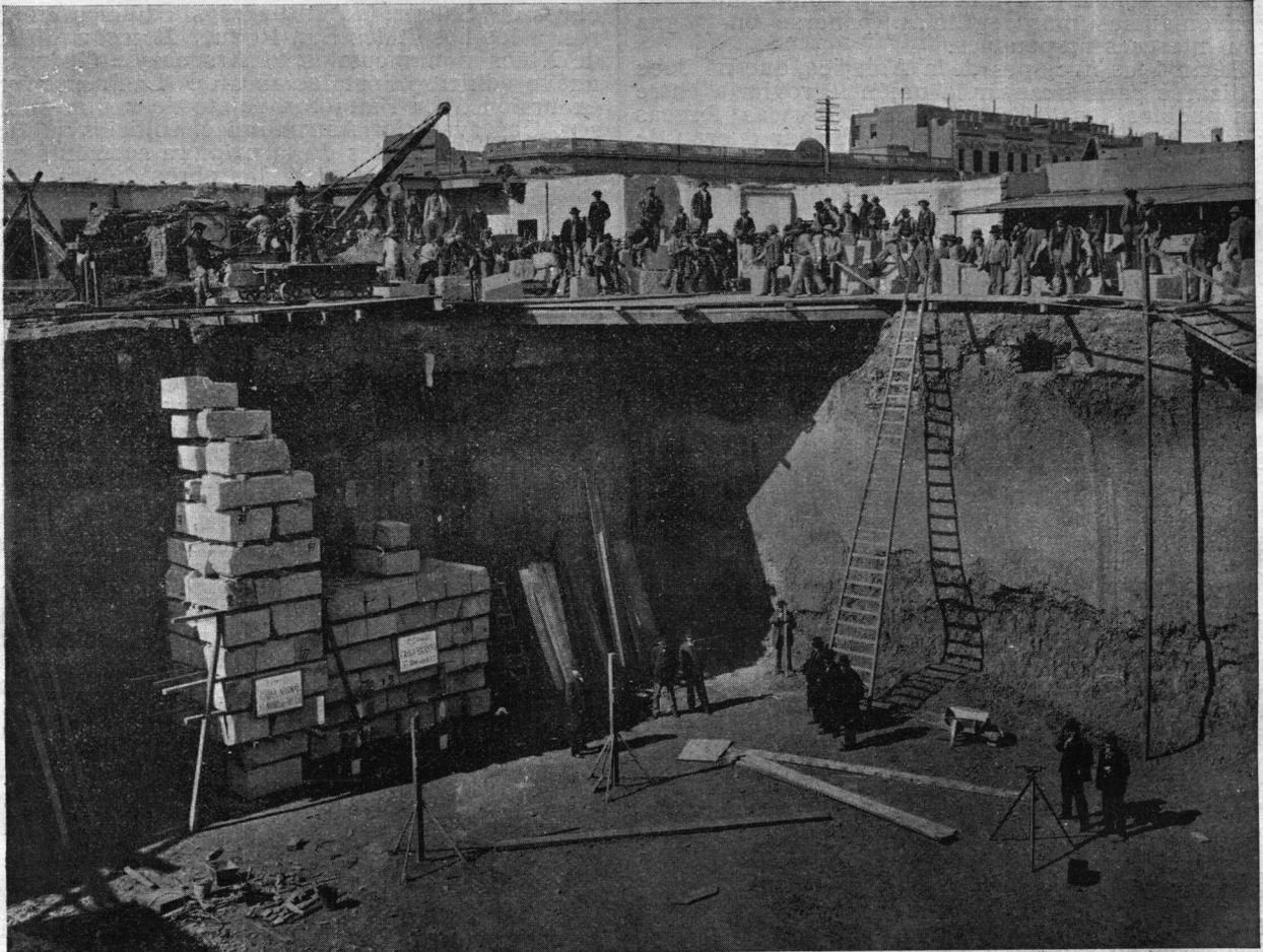
Fig. 1.—Pruebas de resistencia del suelo para la fundación de la torre central del Palacio del Congreso
