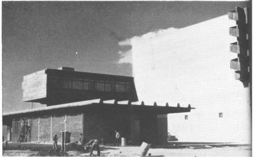
1: Desde el pie del tanque de agua y detrás de la portería, en primer plano, se ve a la derecha la gran caja de hormigón armado que protege la sala de máquinas de la usina y más atrás el puente de control con su sala de tableros y oficinas administrativas.
