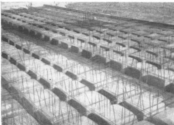
De arriba abajo: Tanto la losa casetonada como la plana de cubierta superior forman amplios aleros que protegen las paredes vidriadas del excesivo resplandor solar. La galería perimetral deja ver la losa casetonada en la toma de sus columnas. En la foto inferior se aprecia en detalle el proceso de construcción de los casetones, como se explica más arriba.
