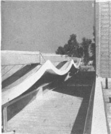
otra inferior de 2.210 m<sup>2</sup>. destinada al envasado de los mismos. Previstas para sobrecarga útil de 1,5 toneladas por metro cuadrado y con luces de 6x10 mts., las naves están cubiertas por losas de hormigón armado, plegadas en el sentido transversal, que facilitan la iluminación y ventilación.
