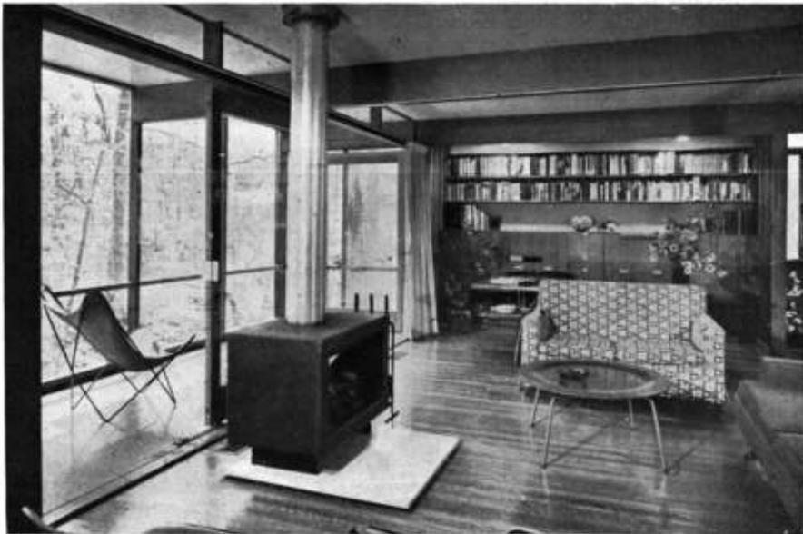
Estas vigas y pilares distinguen los ambientes para las diferentes actividades en el interior. Para contrabalancear la estructura rígida, cálidas superficies de madera terciada o simple abundan por el interior y aparecen en el exterior. La planta es de sencillez excepcional y la aproximación entre cocina y baño fué deliberada para ahorrar cañerías. El jardín, en la parte elevada del terreno, fué cuidadosamente elaborado.
