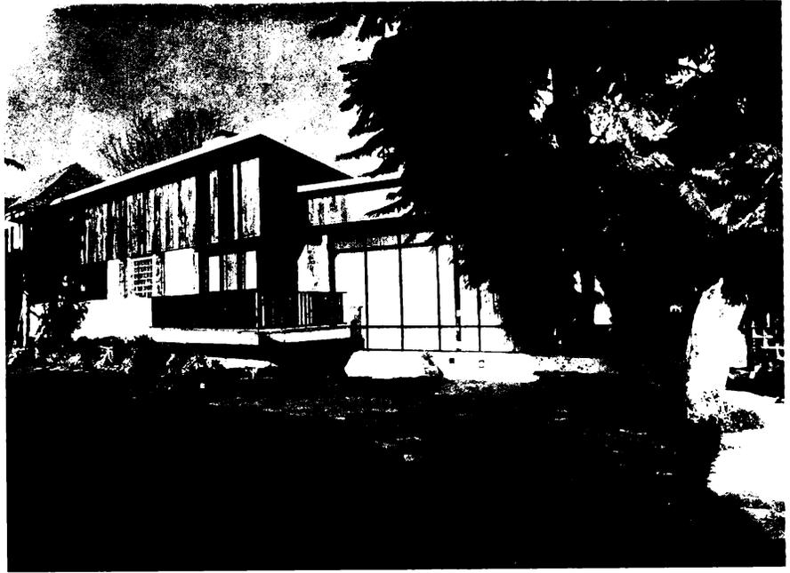
Vista al jardín. Parte superior revestida en tablas de cedro enceradas, zócalo de piedra Mar del Plata y mampostería de ladrillo en doble pared con cámara de aire. Se ha solucionado el cerramiento de las ventanas con cortinas a mallas, siendo la del gran ventanal accionada por motor eléctrico.
