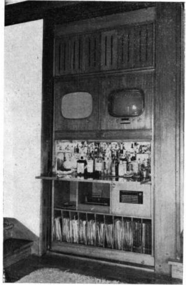
Vista del bar. La puerta es corrediza y está formada por tabloncitos de 46 mm. de espesor machihembrados y unidos con tres espigas de madera dura pasantes. El bar tiene tapa volcable revestida con formica negra y el interior está cubierto por espejos y posee un estante de cristal para copas. La parte superior de este mueble está destinada a alojar los aparatos amplificadores de la radio y la pantalla de televisión (vista 3).
