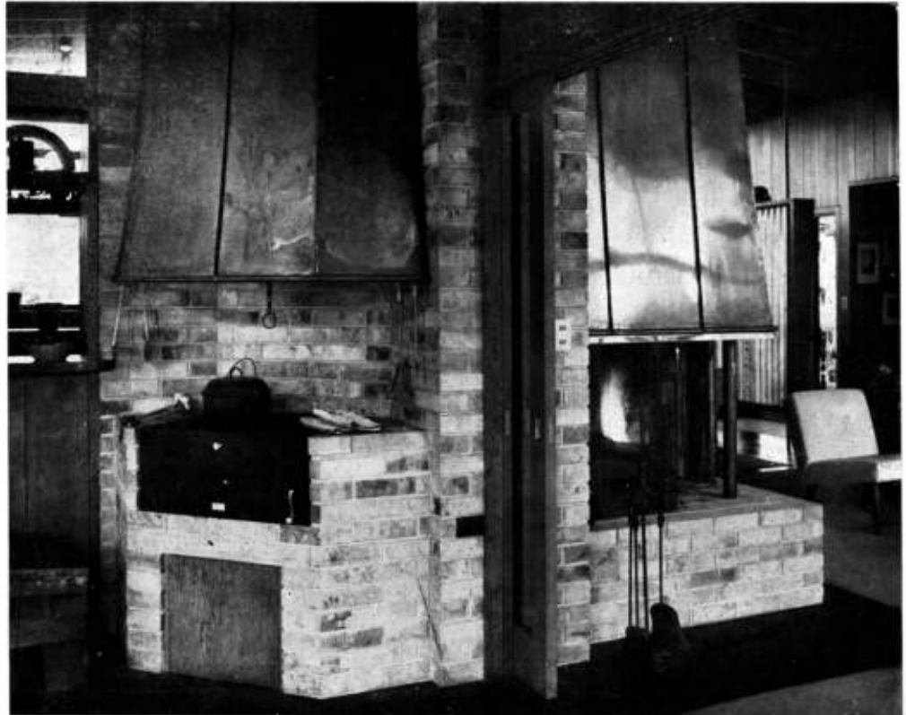
La campana de la chimenea (living) y la de la parrilla (patio) son de cobre. En la chimenea se usó como guardachispas una cortina de cadenas metálicas. El conjunto se construyó con ladrillos refractarios.
