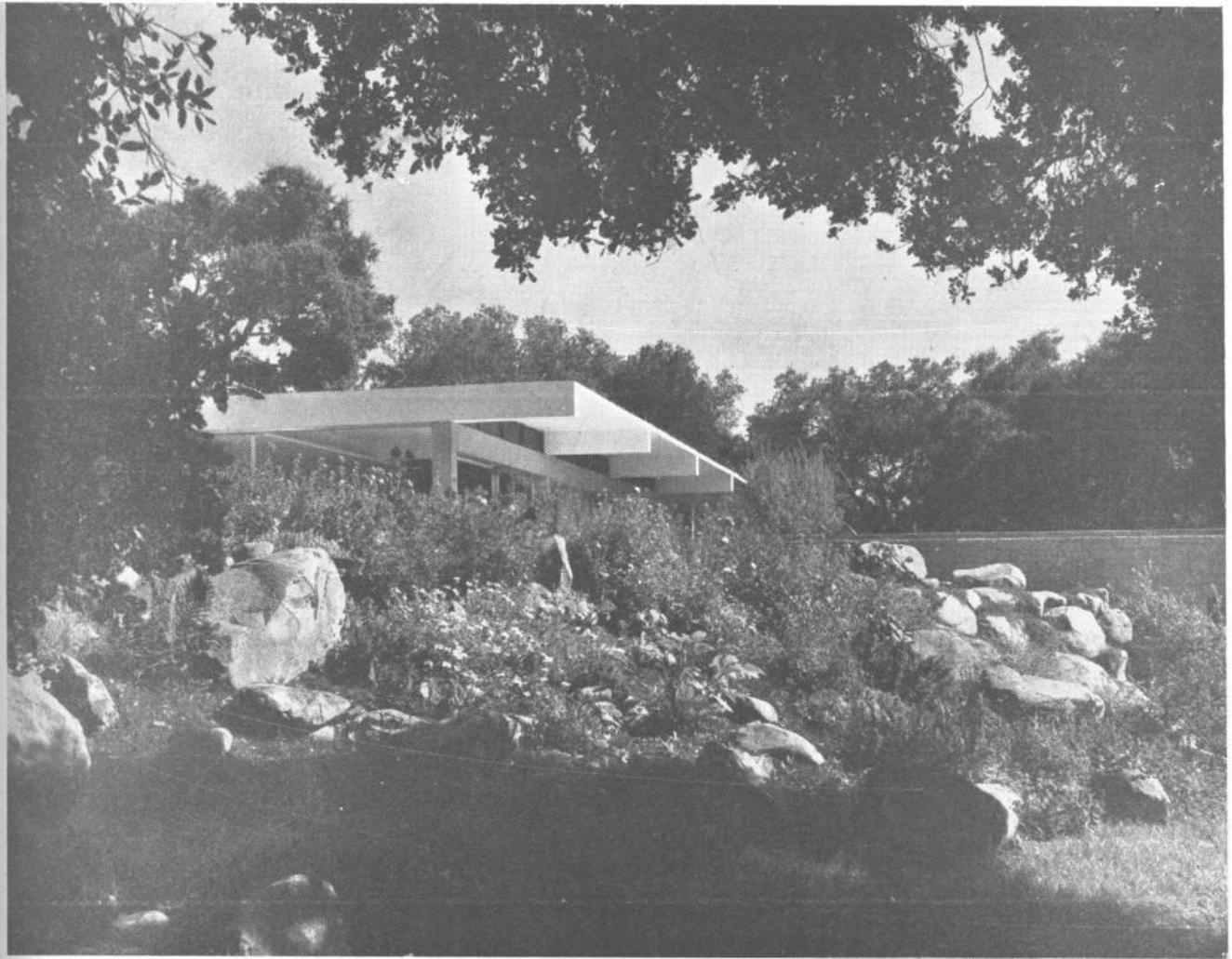
Una losa de hormigón de 0,125 se asienta sobre un sistema de vigas transversales de 0,19 de espesor y 0,40 de alto, espaciadas a 4,80, que descansan en vigas frontales. Matas en un jardín rocoso forman el primer plano de esta regularidad clásica. Su blancura se realza por el contraste de las copas oscuras de los árboles que quedan detrás.
