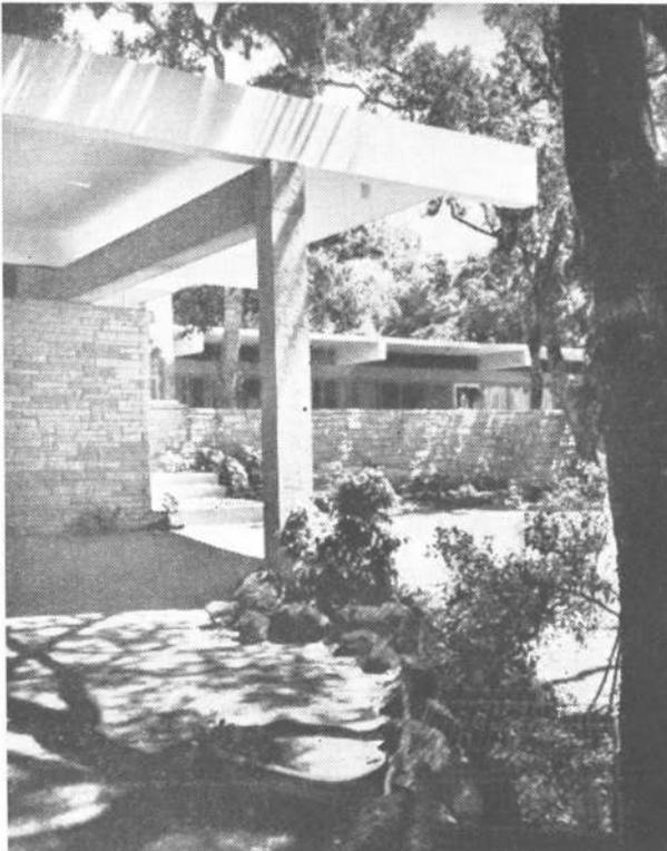
Vista desde la "porte-cochere". En primer plano la columna de hormigón que sostiene la losa del techo. La viga continúa en el interior. En ninguna parte se ha usado yeso.
