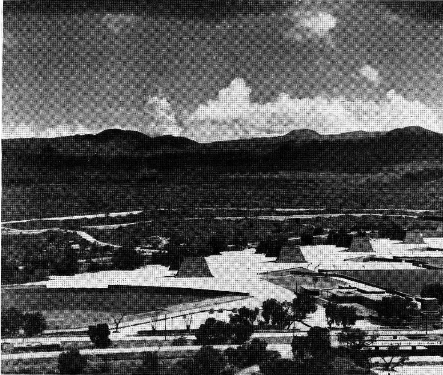
Vista general de la sección deportiva de entrenamiento
