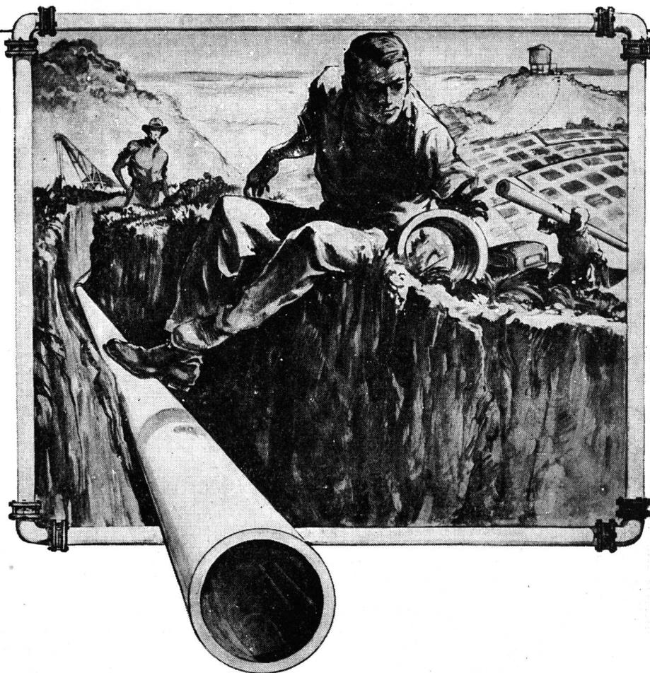
Los caños de asbesto cemento ETERNIT, fabricados de acuerdo a las normas de O. S. N. se adaptan especialmente para la ejecución de redes de distribución de agua potable a poblaciones o loteos. Sus paredes interiores completamente lisas, evitan las incrustaciones y resisten a las aguas más agresivas.
