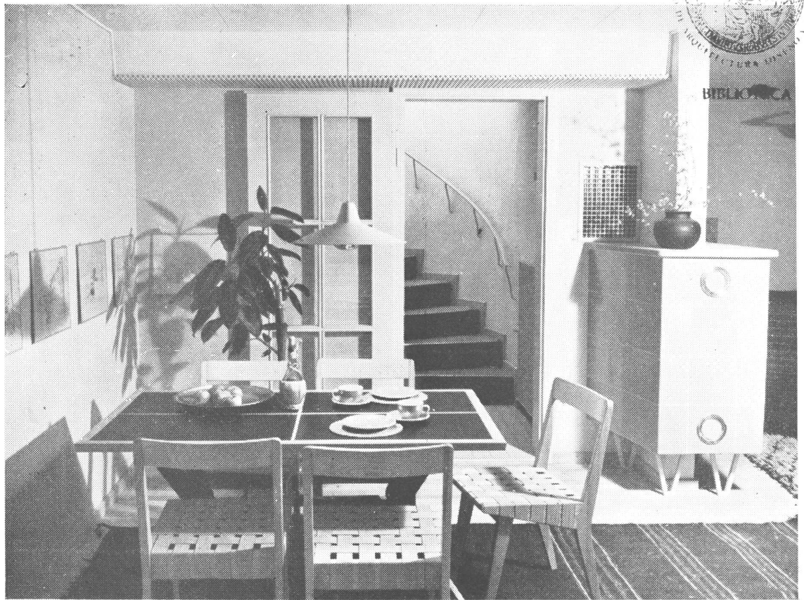
Detalle del rincón comedor. En la parte del cielo raso rebajado sobre la puerta, pasa el conducto en fibrocemento para la calefacción y el agua caliente en el piso superior. Al fondo, la escalera al piso superior.
