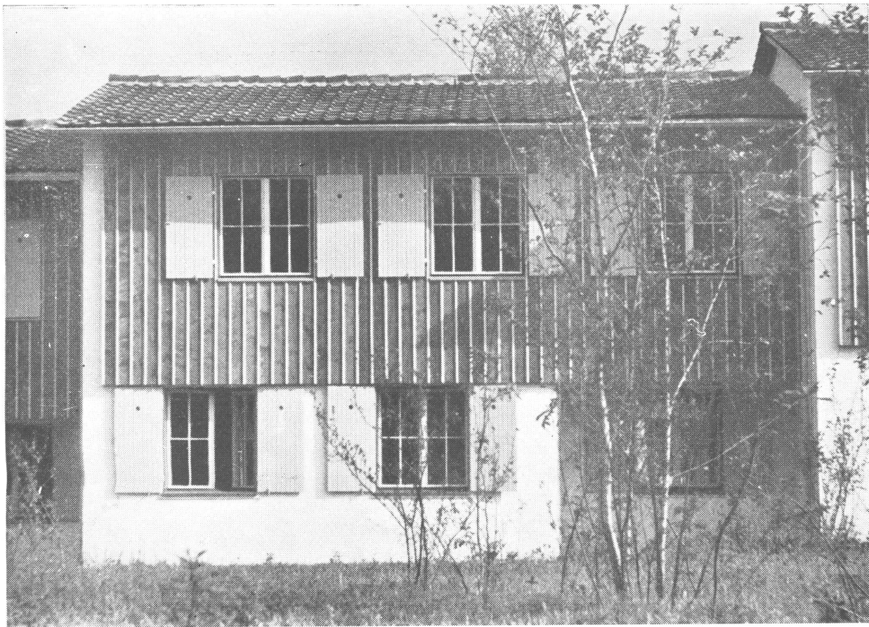
Detalle de una casa tipo D. Todas las ventanas llevan vidrio doble.
