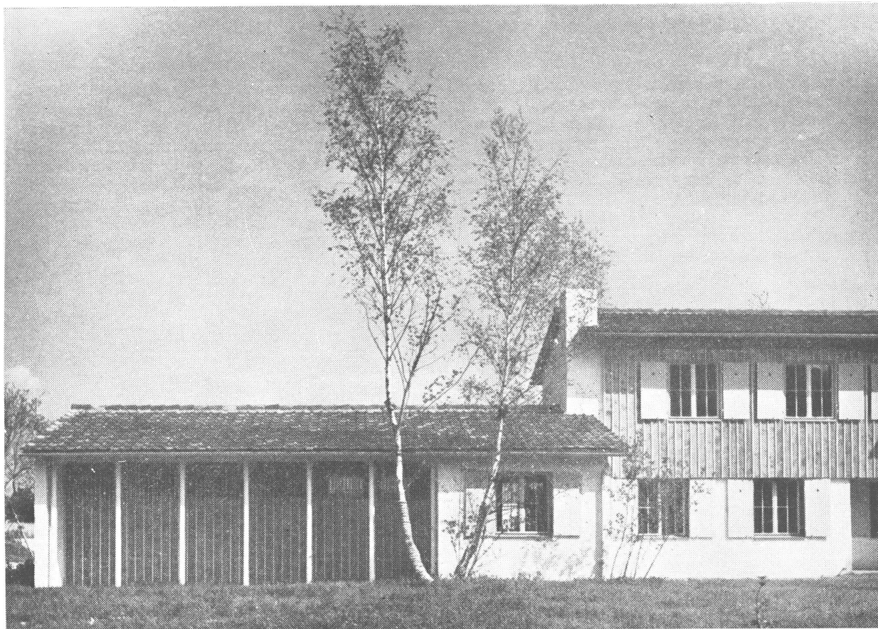
Lavadero anexo a las filas de casas de tipo D. La construcción es de un solo piso. A la derecha el lavadero; a la izquierda un pórtico cubierto que da sobre el tendedero.
