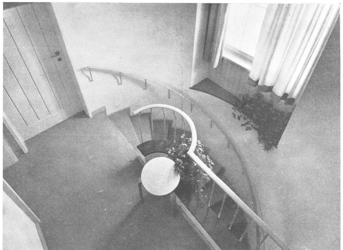
Llegada de la escalera al piso superior. La escalera está formada por escalones prefabricados en cemento armado y recubiertos de linóleo. El pavimento del palier es también de linóleo. Sobre el fondo a la izquierda, la puerta del baño.
