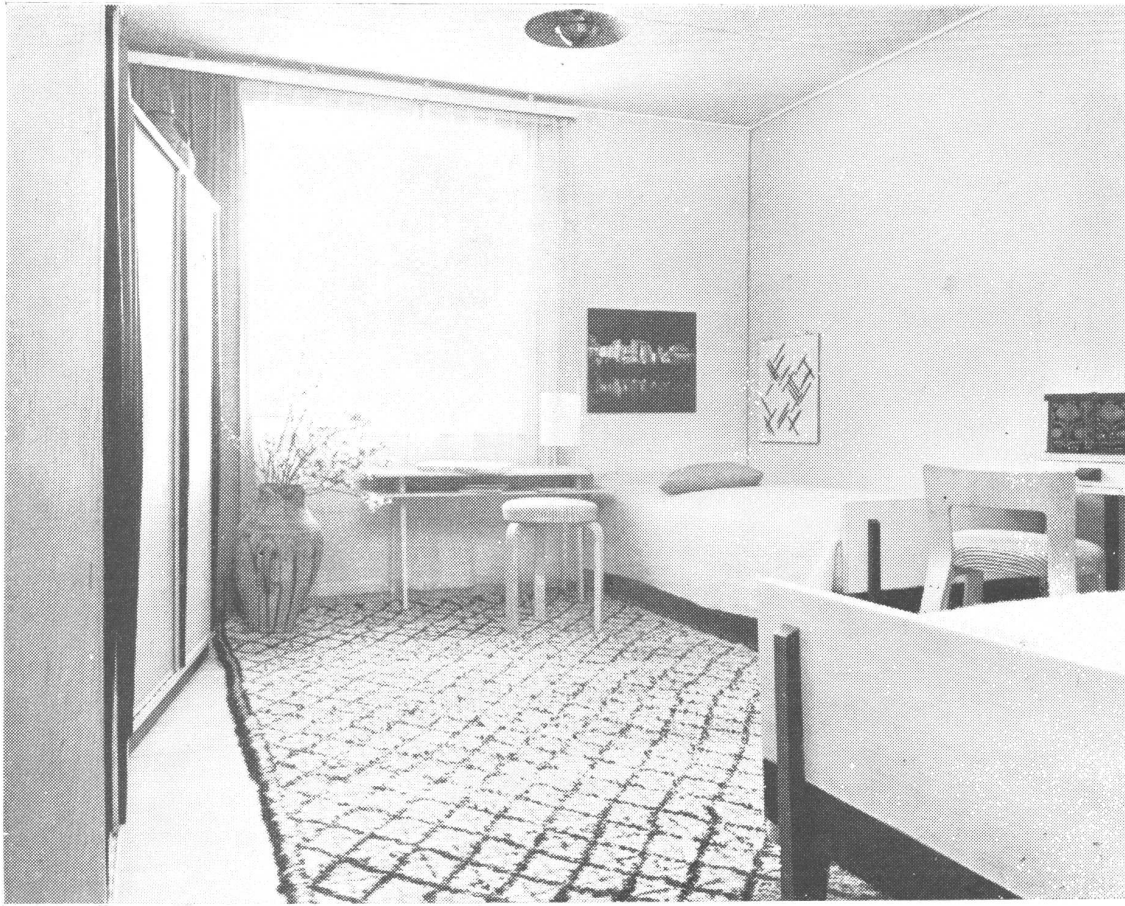
Dormitorio principal. Los muebles son producidos en serie. Piso de madera. Cielo raso y paredes en "pavatex". En la pared externa del fondo, a la derecha de la ventana, hay un elemento de pared móvil que puede ser removido para el transporte de muebles.
