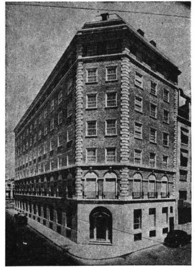
Obra: Hotel Lancaster, Capital. Arqs. Acevedo, Becú y Moreno. Emp. Const Ing. Carlos Agote.
