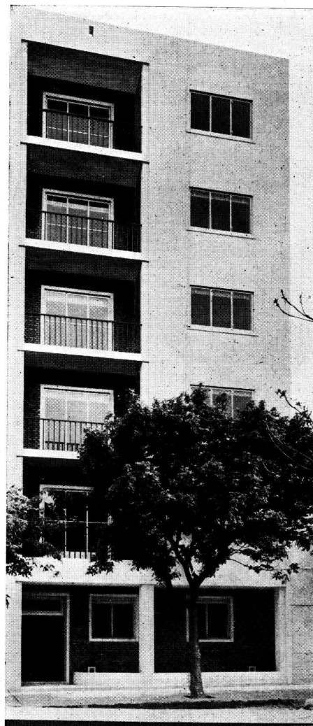
DETALLES DE LA FACHADA
