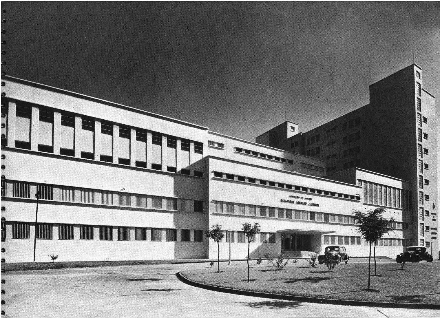
FACHADA PRINCIPAL — CUERPO "A"
