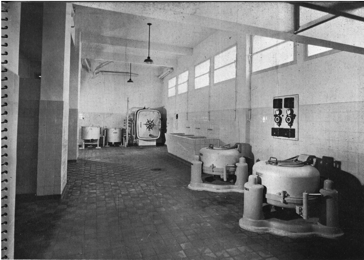
LAVADERO — SECCION DESINFECCION
