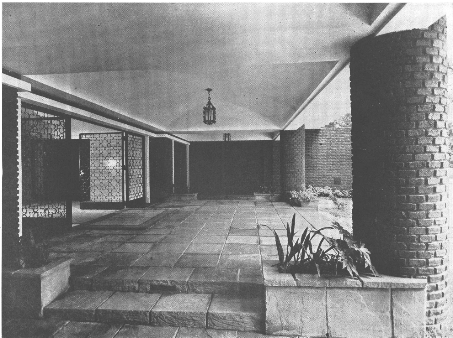
Un detalle del edificio de renta de la calle Pampa 1830. — El pórtico.
