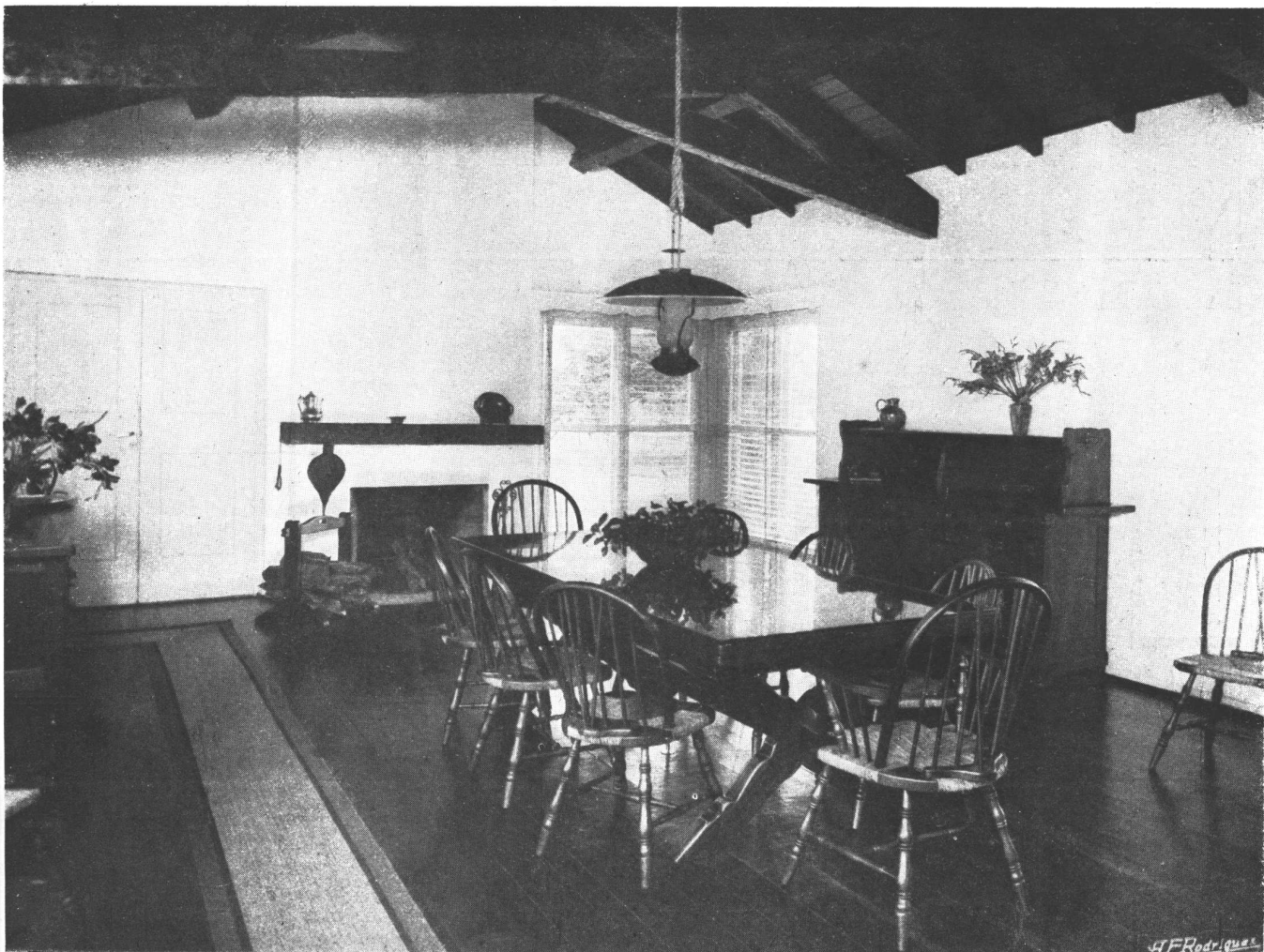
ARRIBA, vista a vuelo de pájaro de las casas existentes, antes de la refacción. ABAJO, el comedor; piso de tablas anchas de lapacho, muros encalados y techado de madera a la vista.
